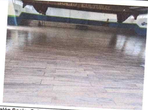
Foto 3: Salón Socio-Cultural Francisco Estrada López. Sustitución de piso de Cerámico.
