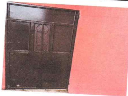
Foto 4: Sustitución de puerta.
