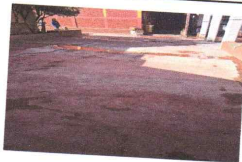
Foto 2: Reparación de planchas de concreto de Patio.
