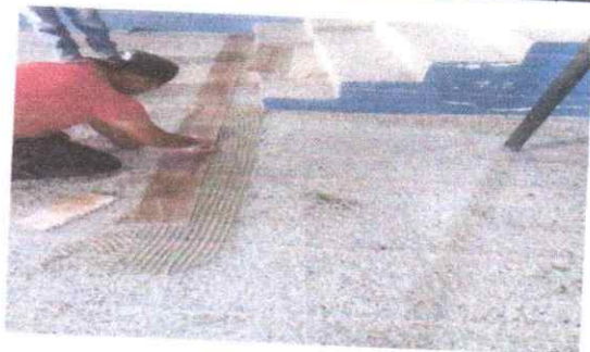
Foto 3: Salón Socio- Cultural Francisco Estrada López. Sustitución de piso de Cerámico.
