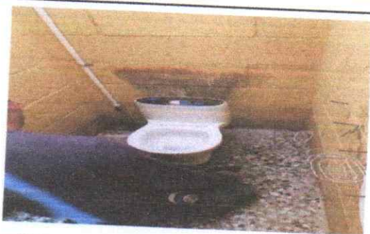
Foto 5: Azulejado en sanitarios y papeleros.
