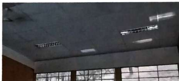
Foto 4: instalación de cielo falso reticulado vinílico
