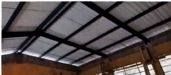
Foto1: sustitución de estructura portante, sustitución de muro
