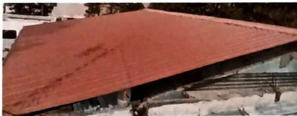
Foto 3: sustitución de lámina por lámina troquelada calibre 26
