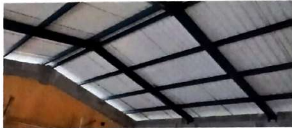
Foto 2: sustitución de estructura portante, sustitución de muro
