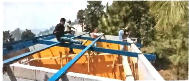
Foto 2: sustitución de estructura portante, sustitución de muro
