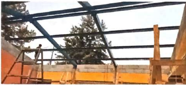
Foto1: sustitución de estructura portante, sustitución de muro
