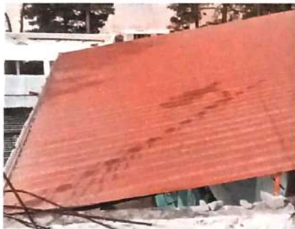
Foto 3: sustitución de lámina por lámina troquelada calibre 26
