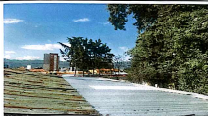
Sustitución de Lamina por Lamina Troquelada Calibre 26
