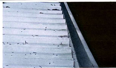
Sustitución de Estructura Portante de techo madera por metal en salón Aula, Sustitución de 12 canal y bajadas de agua pluvial por canal americano calibre 26
