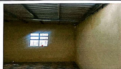
Sustitución de Estructura Portante de techo madera por metal en salón Aula
