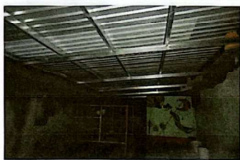
Sustitución de Estructura Portante de techo madera por metal en salón Aula, Sustitución de 12 canal y bajadas de agua pluvial por canal americano calibre 26
