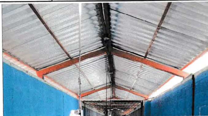
Finalización de instalación de lámina, por lámina troquelada calibre 26 y sustitución de capote metálico
