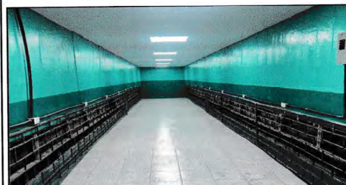
Finalización de pintura látex aplicada a las paredes
