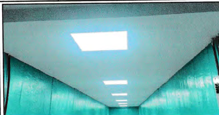
Finalización de instalación de cielo falso de tablayeso
