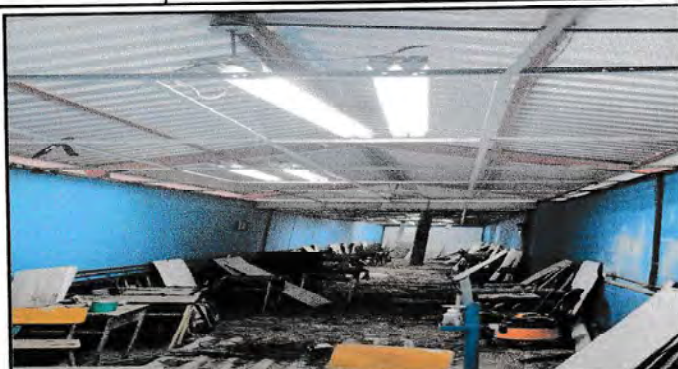
Sustitución de lámina, por lámina troquelada calibre 26Sustitución de capote metálico
