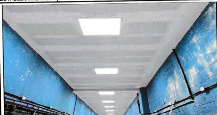
Sustitución de cielo falso de tablayesoSustitución de lámparas led empotrables para tablayeso de 60x60 cm
