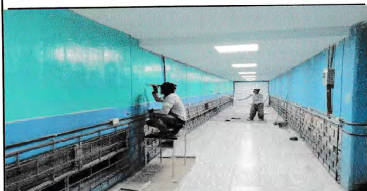
Aplicación de pintura látex
