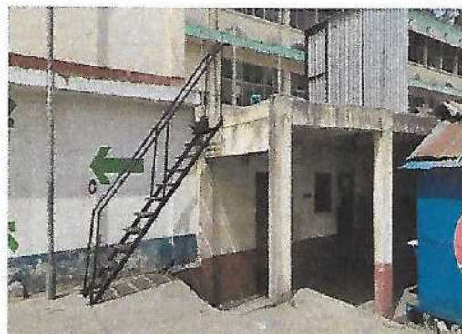
Foto 4: VISTA DE SUSTITUCIÓN DE ESCALERA POR GRADAS CON PASAMANOS
