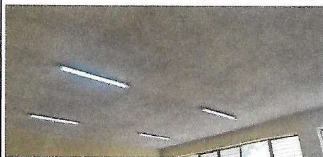
Foto 2: MANTENIMIENTO DE SISTEMA ELECTRICO GENERAL
