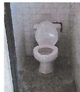
Foto 6: MANTENIMIENTO DE SANITARIOS
