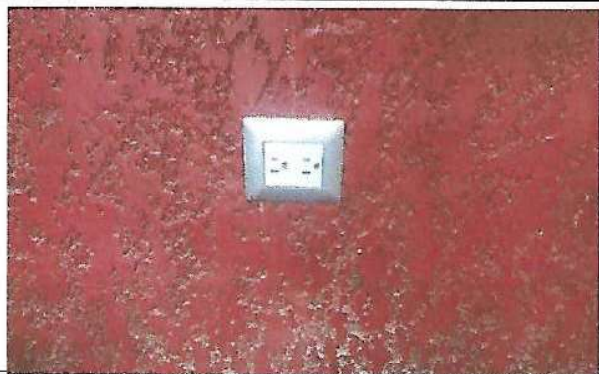
Foto 1: MANTENIMIENTO DE SISTEMA ELECTRICO GENERAL
