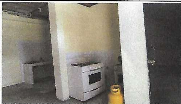
Foto 3: SUMINISTRO E INSTALACIÓN DE LAVAPLATOS Y AMPLIACIÓN DE AULA
