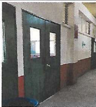
Foto 5: SUSTITUCIÓN DE PUERTAS SEGUNDO NIVEL
