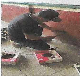
Foto1: RETIRO DE LAMPARAS Y TOMACORRIENTES, MANTENIMIENTO DE RED DE TENDIDO ELECTRICO
