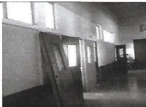
Foto 5: RETIRO DE LA PUERTAS
