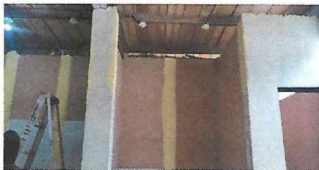
Foto 3: DEMOLICIÓN DE MURO DE LABORATORIO DE EMPRENDIMIENTO PARA LA PRODUCTIVIDAD
