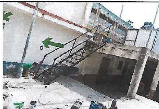
Foto 4: INSTALACION DE GRADAS DE METAL CON PASAMANOS
