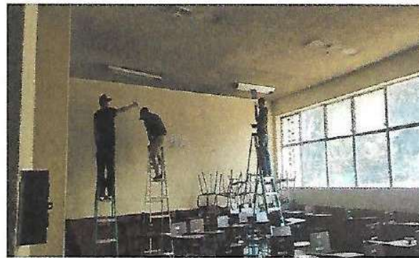
Foto 2: RETIRO TOMACORRIENTES Y MANTENIMIENTO DE TENDIDO ELECTRICO
