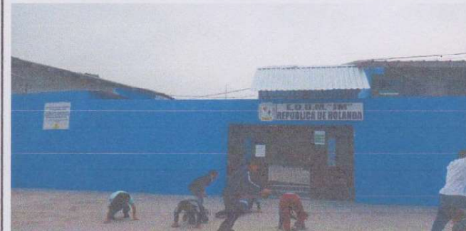
Foto 4: PINTURA INTERIOR Y EXTERIOR
