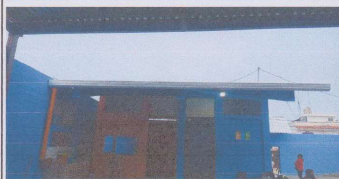
Foto 2: INSTALACIÓN DE CANAL LINEAL CON BAJADA
