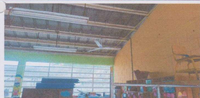
Foto 5: INSTALACIÓN DE VENTILADOR
