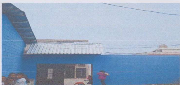
Foto 3: INSTALACIÓN DE TECHO BASE METALICA Y LAMINA TROQUELADA
