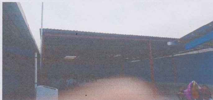
Foto 1: INSTALACIÓN DE ESTRUCTURA METALICA Y LAMINA TROQUELADA
