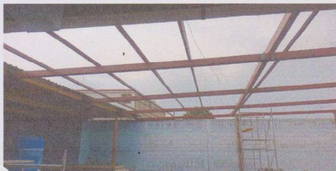
Foto 1: INSTALCIÓN DE ESTRUCTURA METALICA
