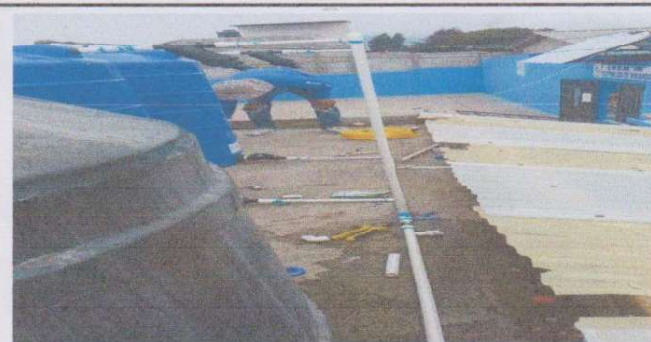
Foto 6: INSTALACIÓN DE DEPOSITO DE AGUA
