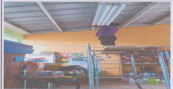
Foto 8 : INTALACIÓN DE VENTILADOR DE TECHO
