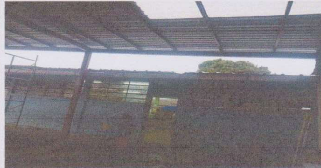
Foto 2: INSTALACIÓN DE LAMINA TROQUELADA
