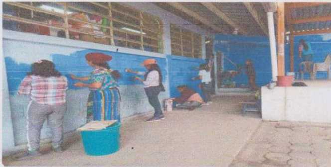
Foto 7 : PINTURA PARA EXTERIOR
