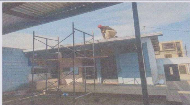
Foto 3: INSTALACIÓN DE CANAL
