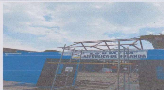
Foto 4: INSTALACIÓN DE TECHO BASE METALICA A 2 AGUAS
