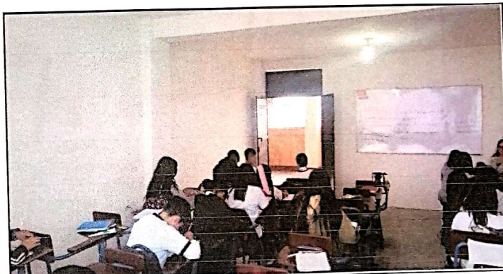
Foto 4: MUROS CON REPELLO
