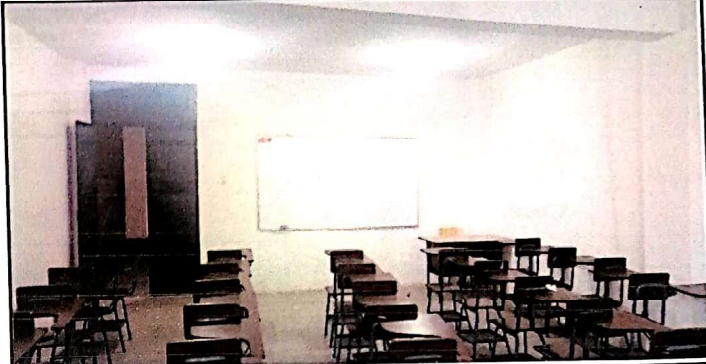
Foto 2: MUROS CON REPELLO
