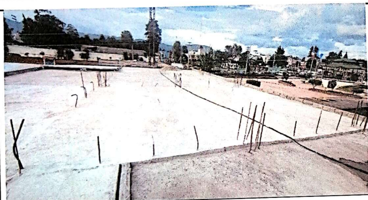
Foto 3: PAÑUELOS E IMPERMEABILIZACION DE TERRAZA
