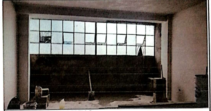
Foto 2: MUROS CON REPELLO
