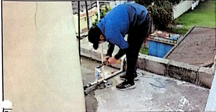
Foto1: INSTALACION DE TUBERIAS
