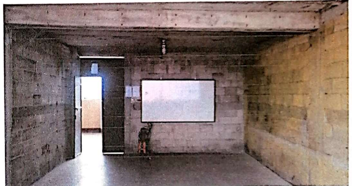
Foto 4: MUROS CON REPELLO
