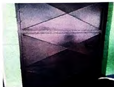
Mantenimiento de puerta metalica
