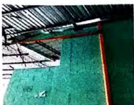
Sustitución de bajadas de agua pluvial
