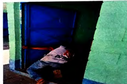
Mantenimiento de puerta metálica
