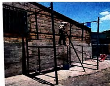
Aplicación de repello e impermeabilizante
