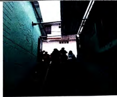
Sustitución de techo de módulos de gradas
