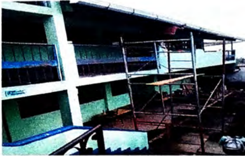
Sustitución de bajadas de agua pluvial
