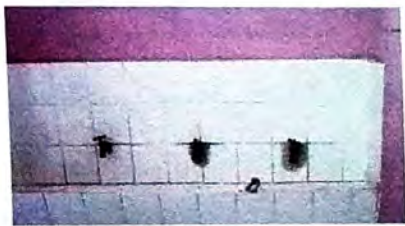
sustitución de chorros para lavamanos
