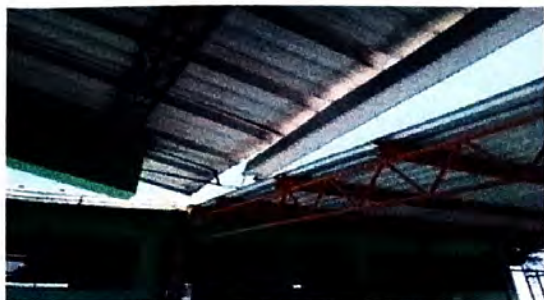
Sustitución de bajadas de agua pluvial
