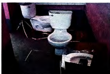
Sustitucion de inodoros
