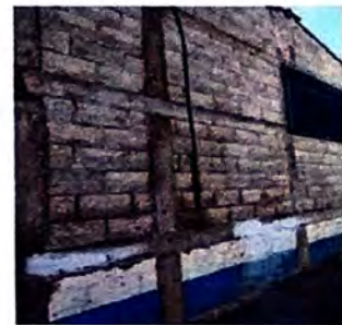
Aplicación de repello e impermeabilizante
