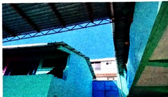
Sustitución de techo de modulos de gradas
