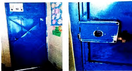
Mantenimiento de puerta metalica
