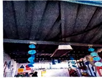
Instalación de cielo falso
