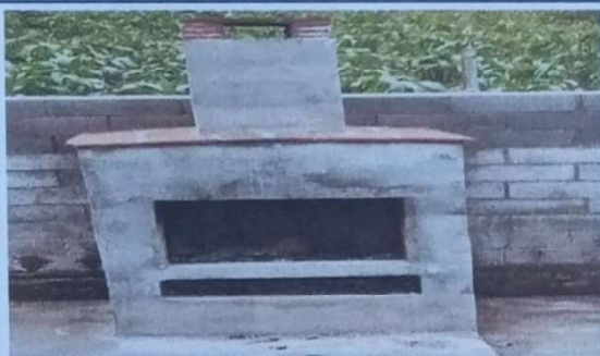
Sustitución de basurero incinerador
