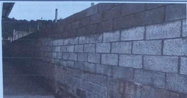
Sustitución de muro de contención
