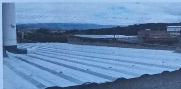
Sustitución de techo de cocina
