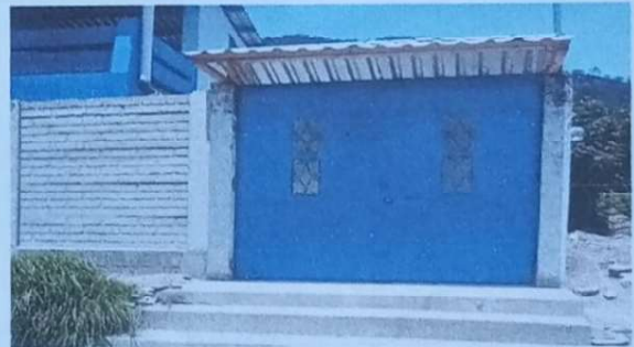
Sustitución de portón de metal
