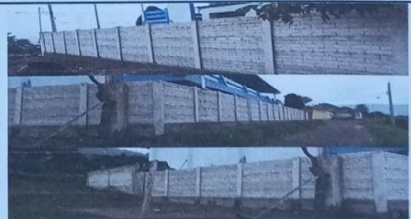
Sustitución de muros perimetral con barda prefabricada de concreto
