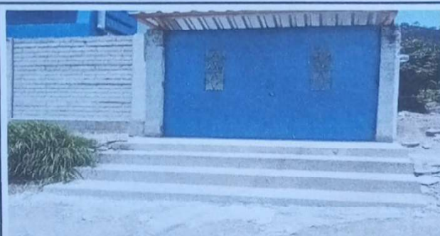
Sustitución de gradas
