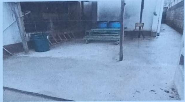
Sustitución de piso de torta de cemento
