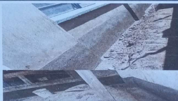
Suministro y aplicación de impermeabilizante de pared
