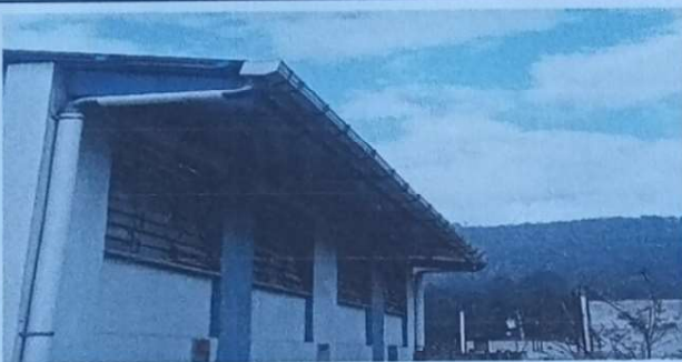
Reparación de canal de metal
