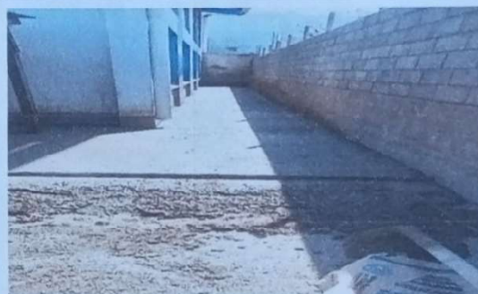
Sustitución de torta de cemento
