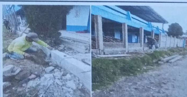
Sustitución de muro perimetral con barda prefabricada de concreto
