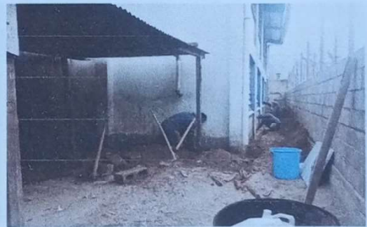
Suministro y aplicación de impermeabilizante de pared
