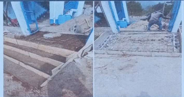
Sustitución de gradas
