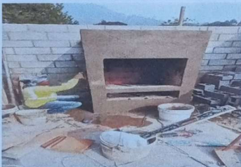
Sustitución de basurero incinerador
