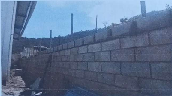
Sustitución de muro de contención
