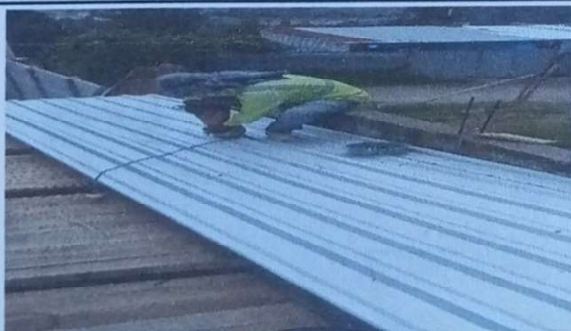
Sustitución de techo de cocina
