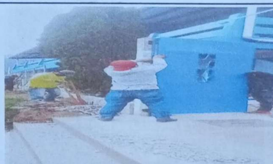
Sustitución de portón de metal
