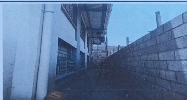
Reparación de canales de metal
