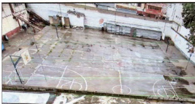
Foto 3: PAÑUELOS EN TERRAZA FINALIZADO
