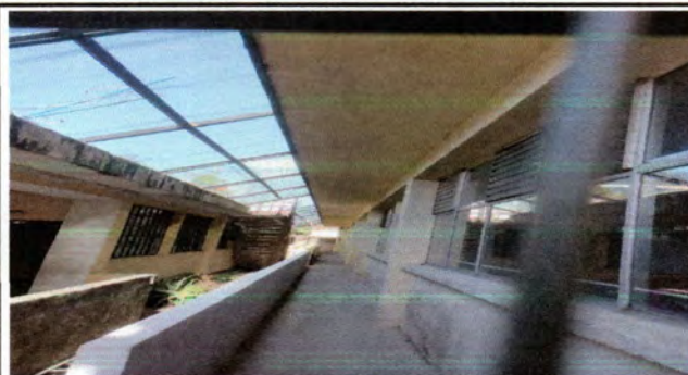
Foto 2: ESTRUCTURA DE LAMINA FINALIZADA
