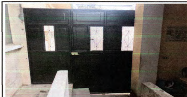
Foto 6: REJA Y PORTON DE PASILLO FINALIZADO
