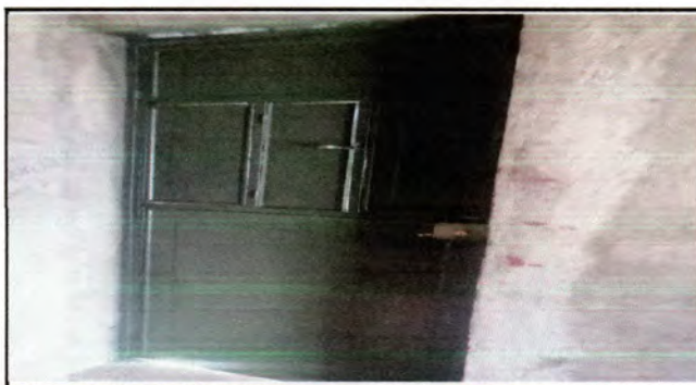
Foto 4: PUERTA COLOCADA Y FINALIZADA
