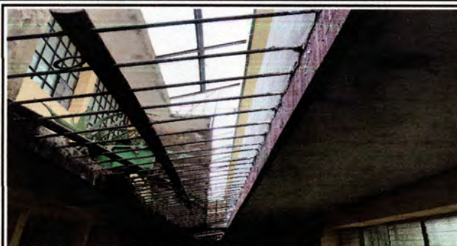
reparacion techo de pasillo sin lamina
