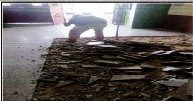
reparacion de piso en entrada
