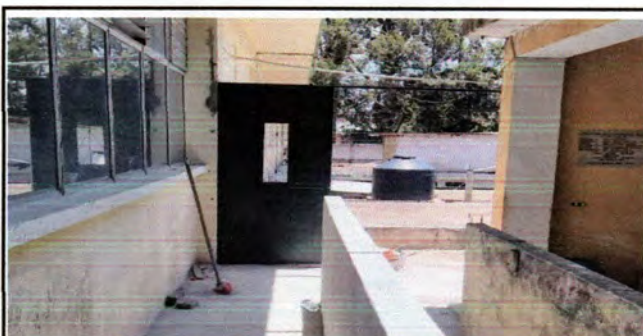
Suministro e instalación de reja en pasillo 2.10 x 2.50mt
