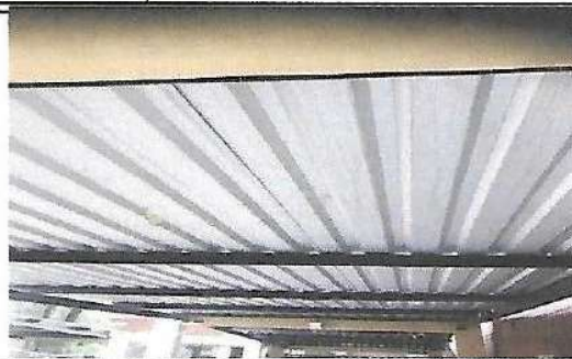
INSTALACION DE ESTRUCTURA METALICA Y CUBIERTA DE LAMINA FINALIZADA
