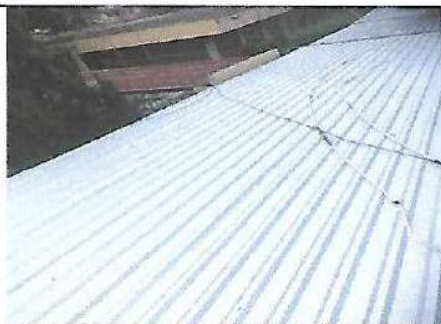
INSTALACION DE ESTRUCTURA METALICA Y CUBIERTA DE LAMINA FINALIZADA
