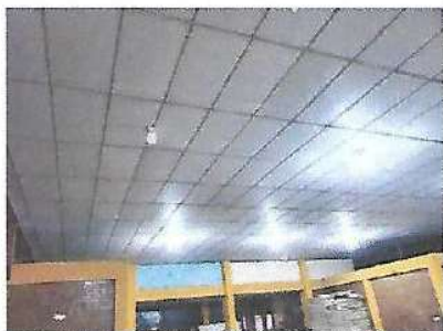
CIELO FALSO ARTICULADO DEL SALON DE USOS MULTIPLES FINALIZADO
