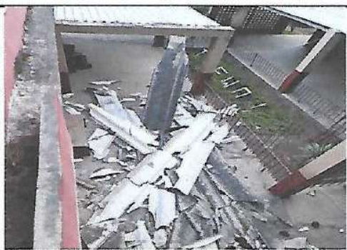
INSTALACION DE ESTRUCTURAS METALICAS MAS CUBIETA DE LAMINA EN PROCESO
