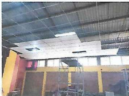
Foto1: INSTALACION DE CIELO FALSO EN PROCESO
