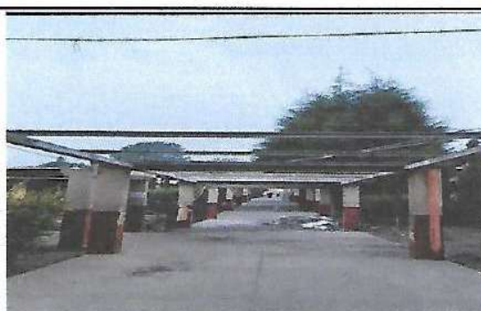
INSTALACION DE ESTRUCTURAS METALICAS MAS CUBIETA DE LAMINA EN PROCESO
