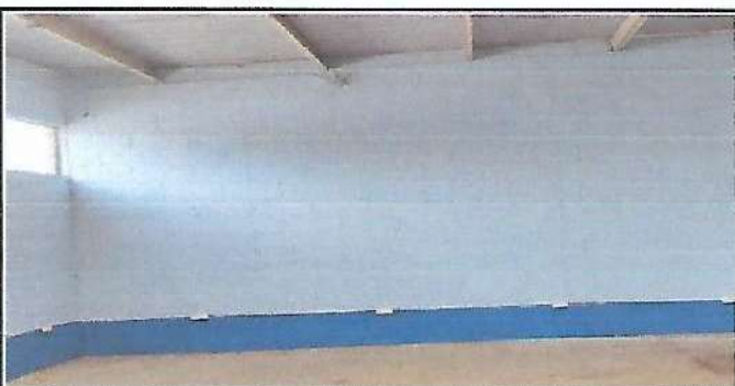
Limpieza de piso, pintura en muros e instalación eléctrica en taller de mantenimiento
