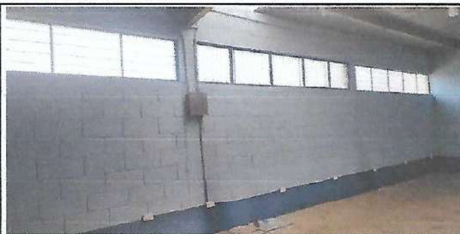
Conexión eléctrica y ventanales listos en taller de Mantenimiento
