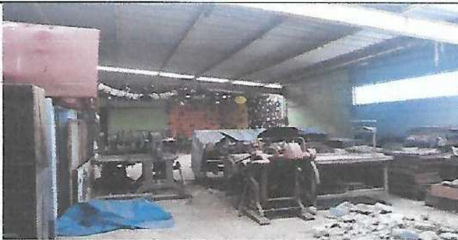
Pintado e instalación de energía eléctrica
