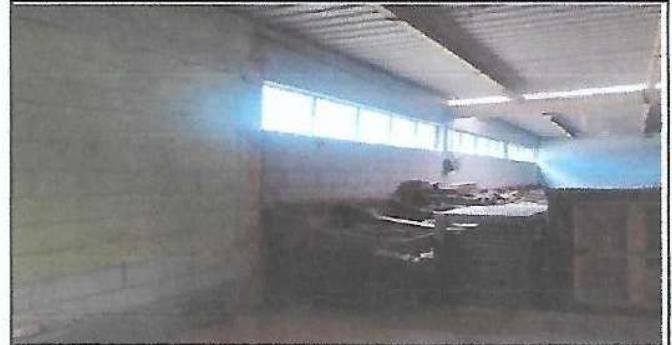
Mantenimiento de muro para ser pintado y resanado
