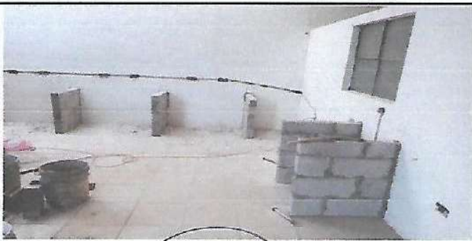
Elaboración de plancha fundida para mesa en cocina
