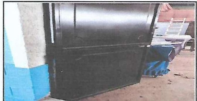
Cambio de puerta de ingreso a Mantenimiento
