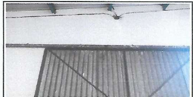
Mantenimiento del porton de acceso a cocina.
