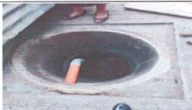
Foto 3: VISTA DE POZO CIEGO
