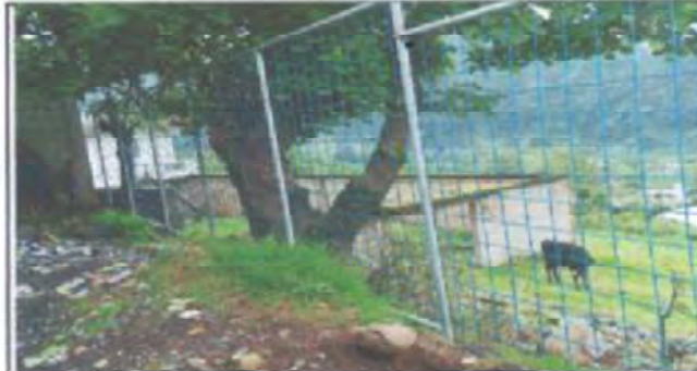
Foto 6: VISTA INTERIOR DE CIRCULACIÓN PERIMETRAL CON ELECTROMALLA A UN COSTADO DE LA ESCUELA FINALIZADO 100%
