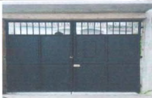
Foto 3: VISTA INTERIOR DE PORTON PRINCIPAL CON CHAPA, MAS FUNDICIÓN DE PESTAÑA EN LA PARTE SUPERIOR, FINALIZADO 100%
