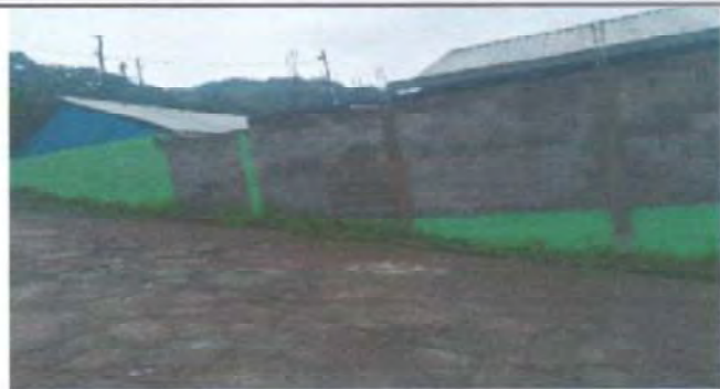
Foto 1: VISTA FACHADA EXTERIOR FINALIZADO 100%
