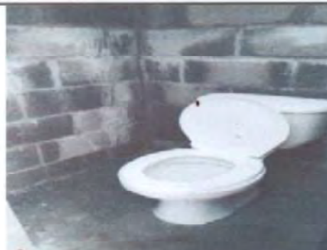
Foto 2: VISTA INTERIOR DE BAÑOS, FINALIZADO 100%
