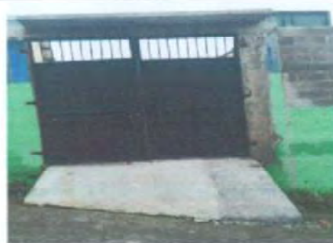
Foto 4: VISTA EXTERIOR DE PORTON PRINCIPAL CON RAMPA, MAS FUNDICIÓN DE PESTAÑA EN LA PARTE SUPERIOR, FINALIZADO 100%
