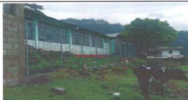
Foto 5: VISTA EXTERIOR DE CIRCULACIÓN PERIMETRAL CON ELECTROMALLA A UN COSTADO DE LA ESCUELA FINALIZADO 100%
