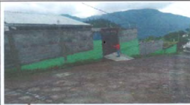
Foto 2: VISTA FACHADA EXTERIOR FINALIZADO 100%
