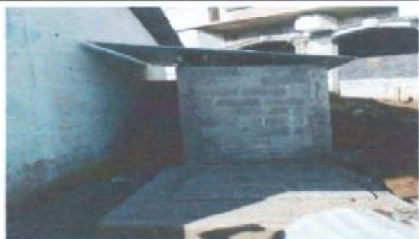
Foto1: VISTA FACHADA EXTERIOR DE BAÑOS FINALIZADO 100%
