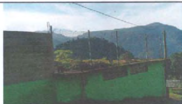
Foto 4: Reparación y colocación de maya sobre la terraza, FINALIZADO 100%
