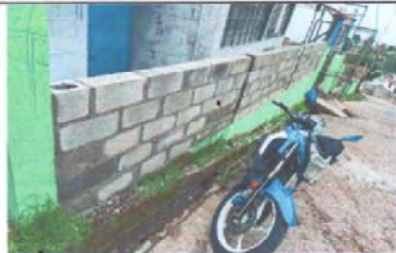
Foto 2: LEVANTADO DE MURO PERIMETRAL CON BLOCK REFORZADO LADO FRENTE DE LA ESCUELA
