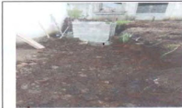
Foto 2: LEVANTADO DE PARED PARA BAÑOS CON BLOCK
