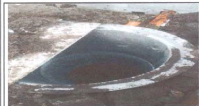
Foto 3: Reparacion de concreto para pozo ciego
