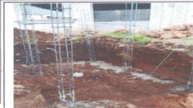
Foto 1: REALIZACIÓN DE CIMENTOS PARA 2 BAÑOS
