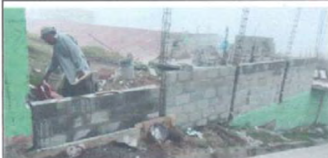
Foto 3: LEVANTADO DE MURO PERIMETRAL CON BLOCK REFORZADO, LADO FRENTE DE LA ESCUELA
