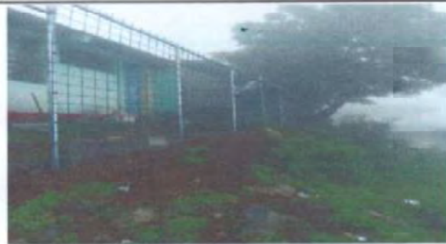
Foto 6: COLOCACIÓN DE ELECTROMALLA A UN COSTADO DE LA ESCUELA
