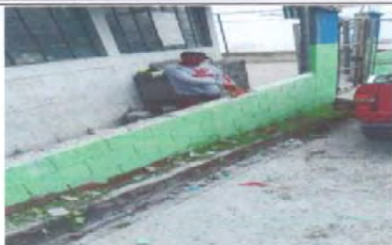
Foto 1: RETIRO DE MALLA METALICA
