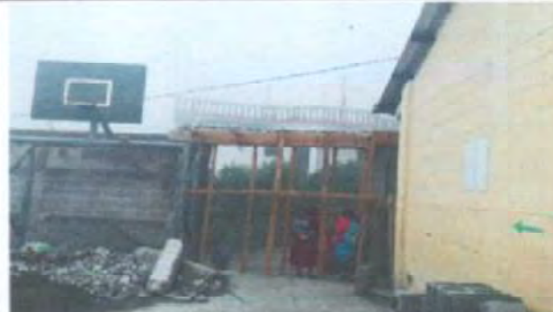
Foto 4: CORTADO DE PARED POR AMPLIACIÓN DE PORTON Y FUNDICIÓN DE MARCO SOBRE EL PORTON
