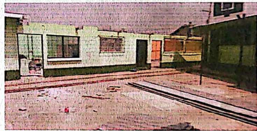
Foto 4: Levantamiento de techo y muro
