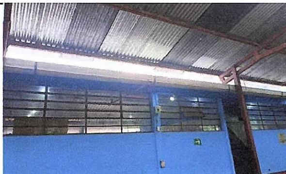
Foto 6: Nivelación de canal módulo 2.
