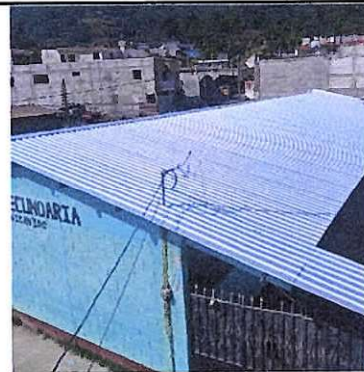
Foto 4: Lámina nueva instalada en techo de módulo 4
