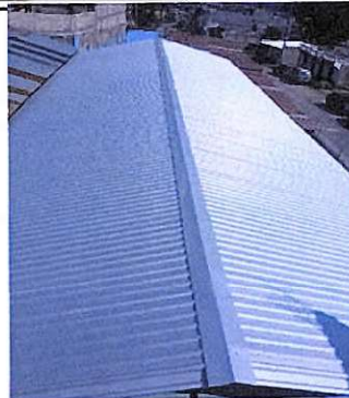
Foto 2: Lámina nueva instalada en techo de módulo 2
