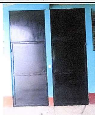
Foto 2: Puertas de módulo 4
