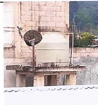
Foto 6: Depósito de Agua 1
