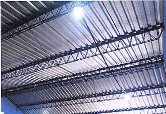
Foto1: Estructura de techo de módulo 2, lijado, pintado y reforzado con tubo metálico.
