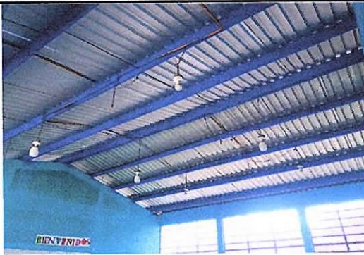
Foto 3: Estructura de techo módulo 4
