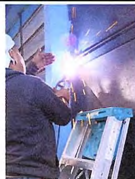
Foto 2: Cambio de bisagra a puertas de módulo 2.
