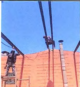
Foto1: Mantenimiento a la estructura de techo del módulo 2, lijado de costaneras
