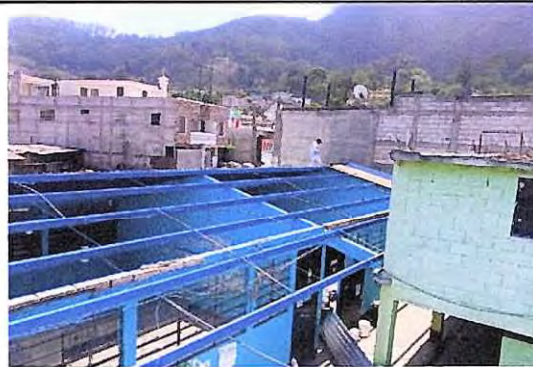
Foto 2: Instalación de lámina nueva en módulo 4
