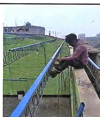
Foto 4: Instalación de tubo de soporte a estructura de módulo 2.
