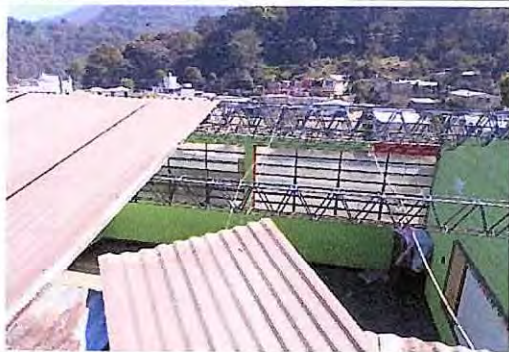
Foto 5: Cambio de lámina del módulo 2.
