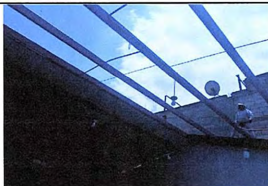
Foto 4: Instalación de lámina nueva en módulo 4
