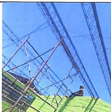
Foto 3: Pintado de estructura de techo módulo 2.
