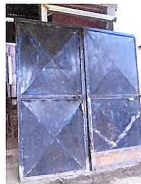
Foto 4: Mantenimiento a puertas, cambio de tubos y lamina de la parte inferior de puertas.
