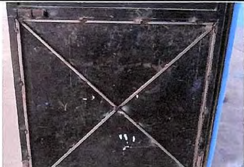
Foto 1: Reforzamiento de puerta, de módulo 2
