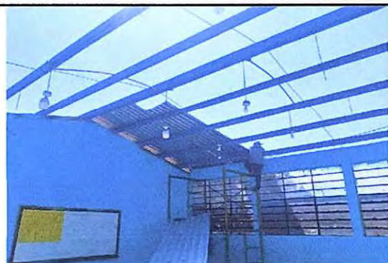
Foto 3: Inicio de instalación de lámina nueva en módulo 4
