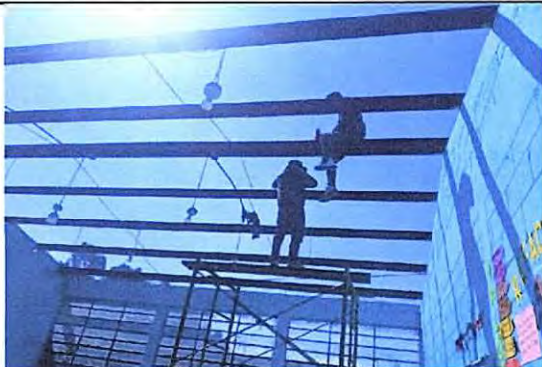
Foto 1: Limpieza y lijado de estructura módulo 4
