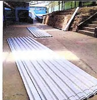
Foto 6: Lámina nueva a instalar en módulo 2.
