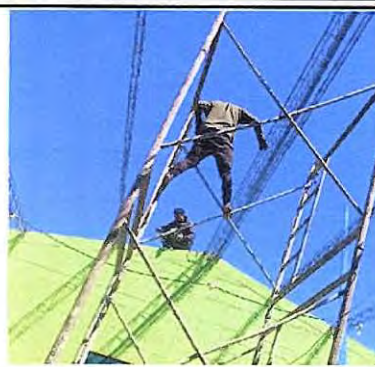
Foto 2: Mantenimiento de estructura de techo módulo 2, lijado de yois.
