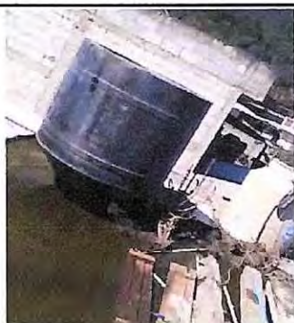
Foto 5: Limpieza de depósitos
