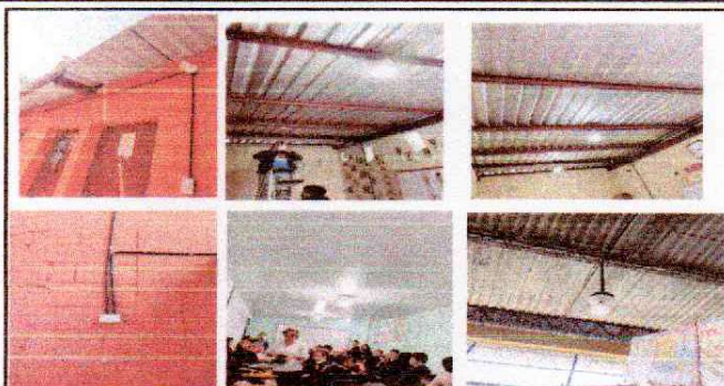
Foto1: FINALIZACIÓN DE CAMBIO DE CABLEADO ELÉCTRICO EN TODA LA ESCUELA
