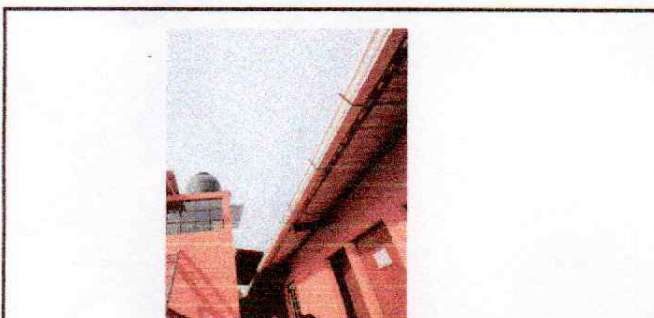
Foto 3: FINALIZACIÓN DE INSTALACIÓN DE CANAL PVC Y BAJADA DE AGUA
