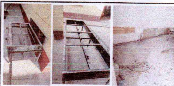
Foto 4: MANTENIMIENTO DE TUBERIA DE GAS Y ESTUFAS
