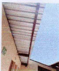
Foto 5: INSTALACIÓN DE CANAL PVC Y BAJADA DE AGUA
