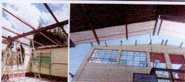
Foto 3: MANTENIMIENTO DE SOPORTE DE METAL EN DOS AULAS
