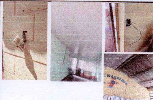
Foto1: RETIRO DE CABLE DE ELECTRICIDAD ANTIGUO
