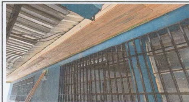
Foto 4: Sustitucion de balcones en las aulas vista exterior
