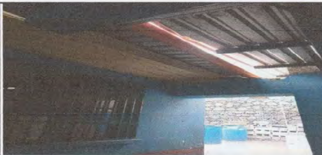
Foto 3:Sustitucion de balcones en las aulas desde la parte frontal
