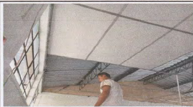
Foto 2: SUSTITUCION DEL CIELO FALSO EN EL AULA DE 3ER GRADO
