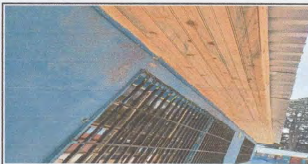
Foto 4: Instalacion y sustitucion en su totalidad del machimbre en aulas de párvulos y 4to grado
