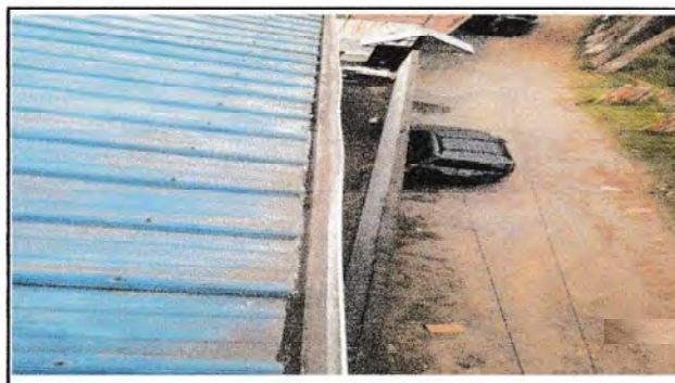
Foto 4: Finalizacion de mantenimiento de canales vista desde parte frontal
