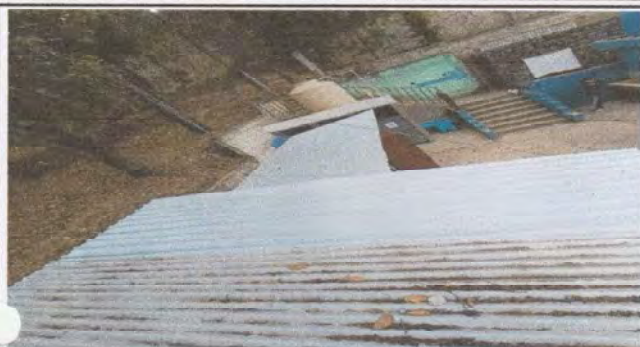
Foto1: finalizacion de la sustitucion de laminas troqueladas en baños
