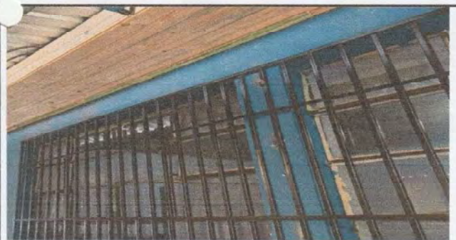
Foto 5: Sustitucion de balcones en las aulas vista exterior
