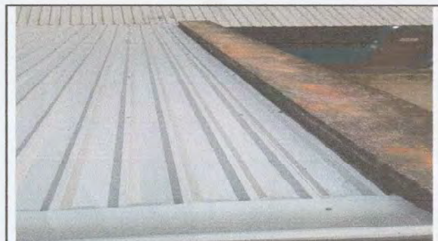
Foto 4: Vista exterior de la colocación de láminas troqueladas calibre 26 en aulas de párvulos, 4to grado, dirección y bodega
