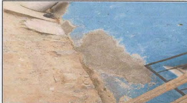
Foto 2: Finalizacion del mantenimiento de paredes de la parte de atrás de aulas de párvulos
