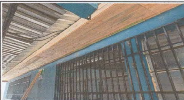
Foto 3: Instalacion y sustitucion en su totalidad del machimbre en aulas de párvulos y 4to grado
