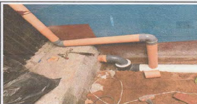
Foto 2: Vista exterior de la colocacion final de la bajada de agua pluvial
