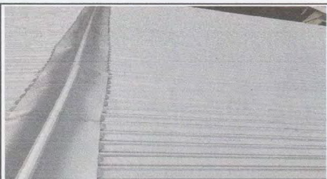
Foto 3: Vista exterior de la colocación de láminas troqueladas calibre 26 en aulas de párvulos, 4to grado, dirección y bodega
