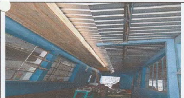
Foto 5: Instalacion y sustitucion en su totalidad del machimbre en aulas de párvulos y 4to grado vista frontal
