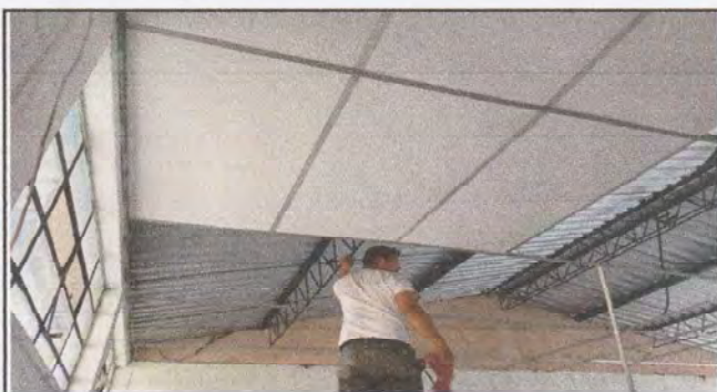
Foto 3: SUSTITUCION DEL CIELO FALSO
