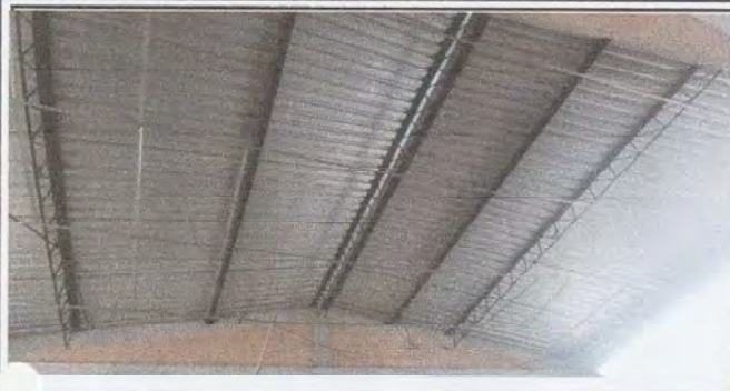
Foto 1: VISTA FACHADA INTERIOR LAMINA COLOCADA AL 100%
