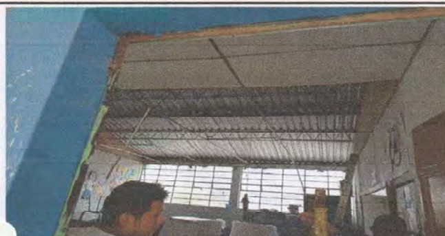
Foto 1: SUSTITUCION DEL CIELO FALSO AULA DE 5TO GRADO
