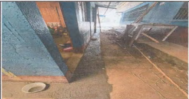
Foto 4: finalizacion de la sustitucion de bajadas de agua pluvial
