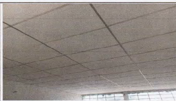
Foto 4: SUSTITUCION COMPLETA DEL CIELO FALSO EN EL AULA DE 5TO GRADO
