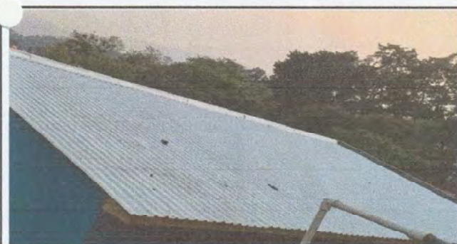
Foto 5: Colocación final de láminas troqueladas calibre 26 en aulas de párvulos, 4to grado, dirección y bodega.
