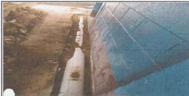
Foto1: Colocacion final de tubos para la bajada de agua pluvial
