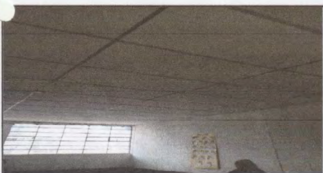
Foto 5: SUSTITUCION COMPLETA DEL CIELO FALSO EN EL AULA DE 3ER GRADO
