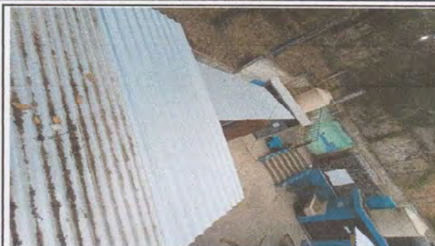
Foto 2: finalizacion de la sustitucion de laminas troqueladas en baños
