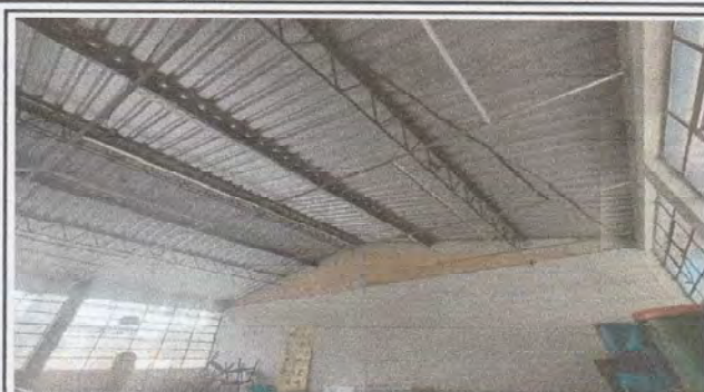
Foto 2: VISTA DE INSTALACIÓN DE LÁMINA FINALIZADO
