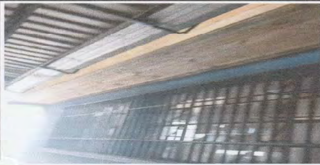
Foto1: Colocacion de los balcones en aulas de párvulos y 4to grado
