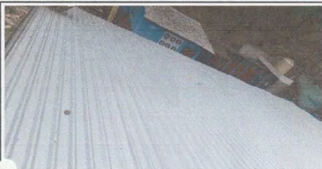
Foto 1: Vista exterior de la colocación de láminas troqueladas calibre 26 en aulas de párvulos, 4to grado, dirección y bodega
