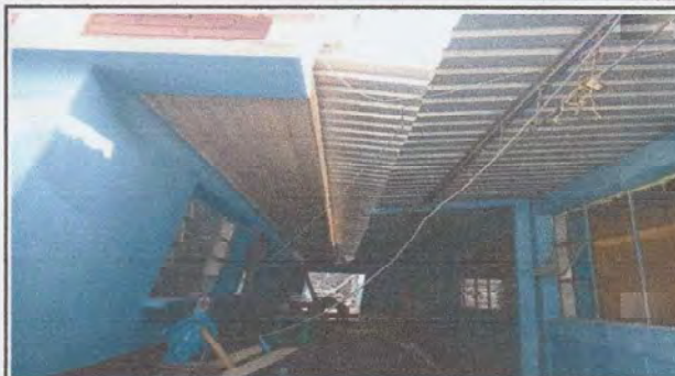
Foto 2: Instalacion y sustitucion del machimbre en aulas de prepa y 4to grado
