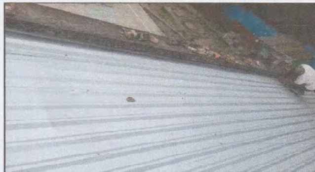
Foto 2: Vista exterior de la colocación de láminas troqueladas calibre 26 en aulas de párvulos, 4to grado, dirección y bodega
