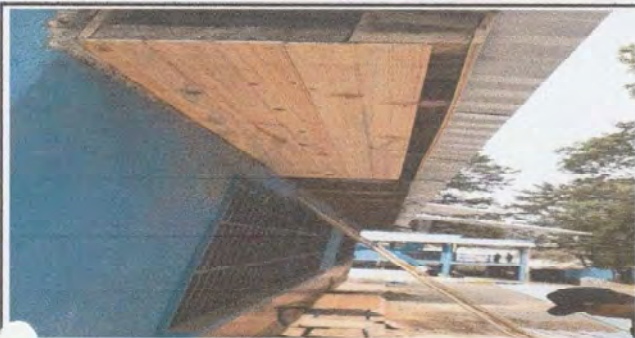
Foto 1: Instalacion en fase inicial del machimbre en aulas de párvulos y 4to grado
