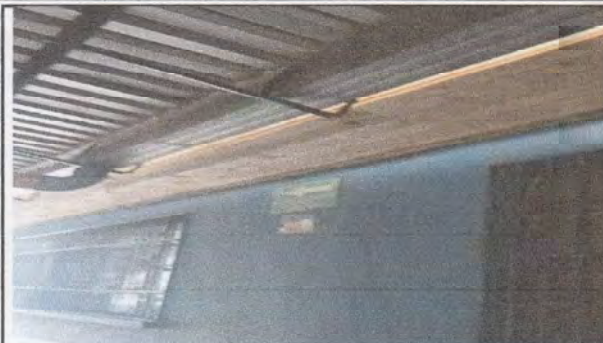
Foto 2: Finalización de la sustitución de canales en aulas
