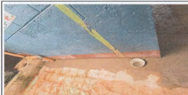
Foto 3: finalizacion de la sustitucion de bajadas de agua pluvial
