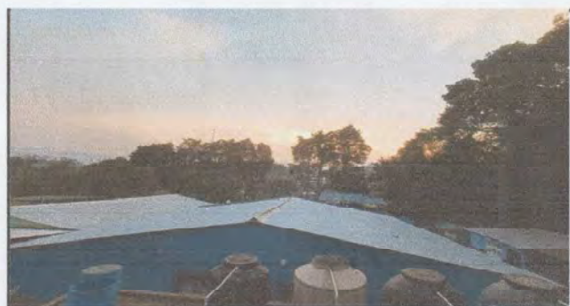
Foto 6: Finalización de la sustitución de lámina troquelada en aulas de párvulos, 4to grado, dirección y bodega
