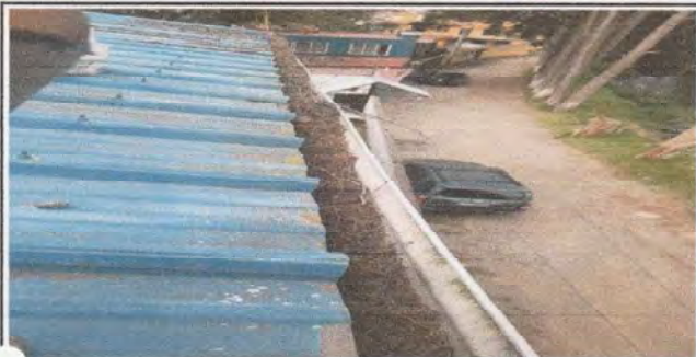
Foto 1: Mantenimiento de canales en au71a de 6to
