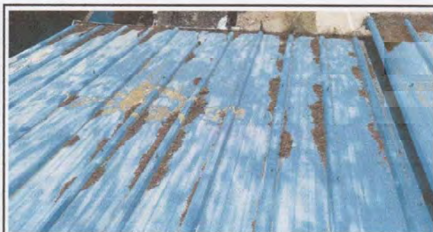
Foto 6: Vista desde arriba el mantenimiento de canales
