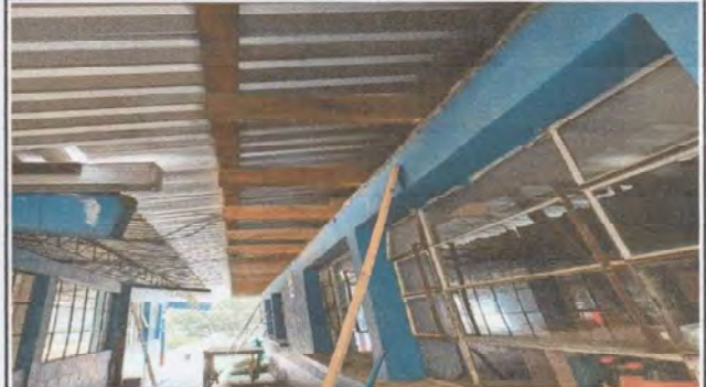
Foto 2: Aulas en proceso de colocar los balcones
