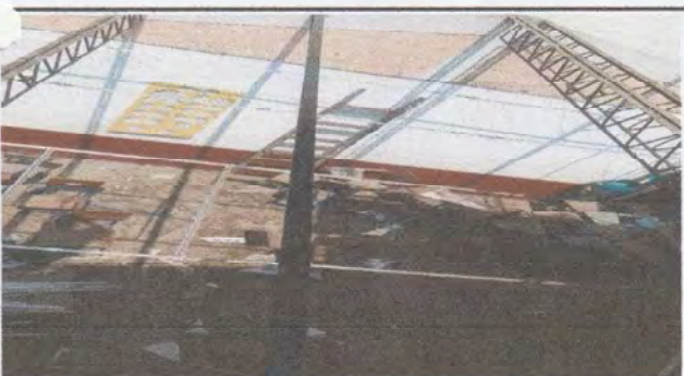
Foto 5: RETIRO TOTAL DEL CIELO FALSO EN EL AULA DE 3ER GRADO
