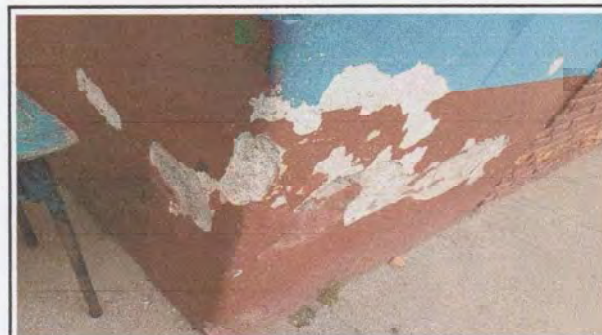
Foto 4: mantenimiento de paredes de la parte posterior
