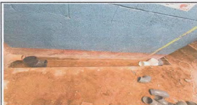
Foto 3: sustitucion de tubos para colocar las bajadas de agua pluvial vista interna
