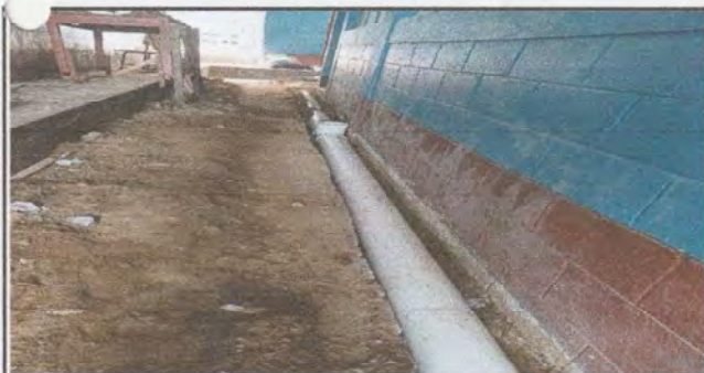
Foto 5: colocacion de tubos para la bajada de agua pluvial vista frontal
