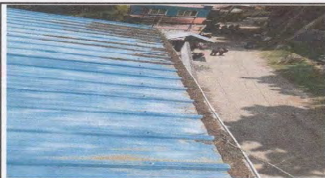
Foto 3: Vista desde arriba el mantenimiento de canales
