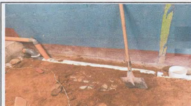
Foto 4: sustitucion de tubos para colocar las bajadas de agua pluvial vista interna
