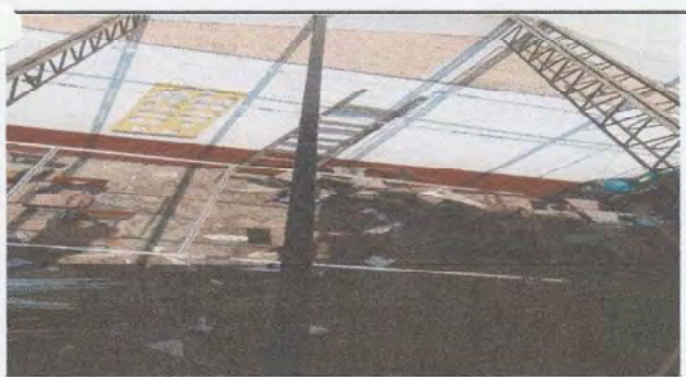
Foto 5: RETIRO TOTAL DE LAMINAS EN AULA DE 3ER GRADO
