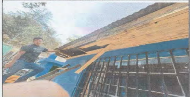
Foto 2: Retiro de machimbre en aulas de parvulos y 4to rado
