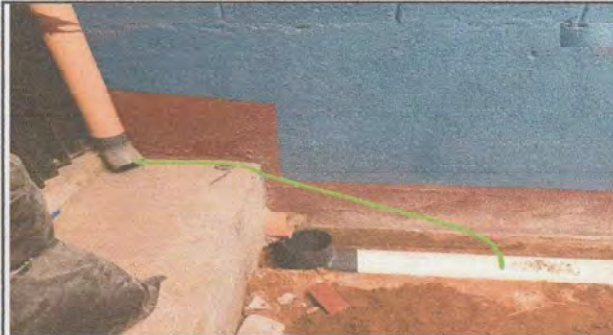
Foto 2: Cambio de tubos para la bajada de aguas pluviales
