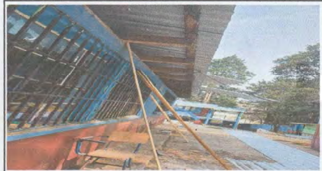
Foto 4: retiro total de machimbre en aulas de párvulos y 4to grado
