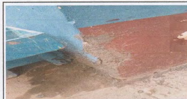
Foto 6: Mantenimiento de paredes parte de al lado
