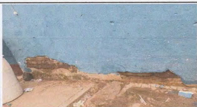
Foto 3: Mantenimiento de paredes parte trasera
