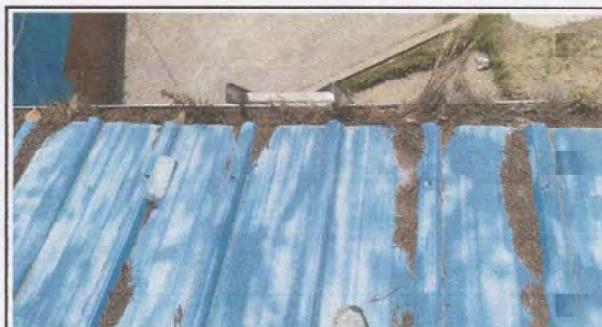
Foto 4: Vista desde arriba el mantenimiento de canales
