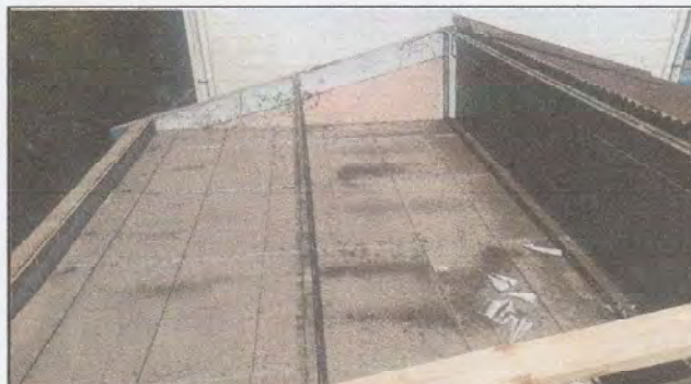
Foto 4: RETIRO DE LÁMINAS EN EL AULA DE 3ER
