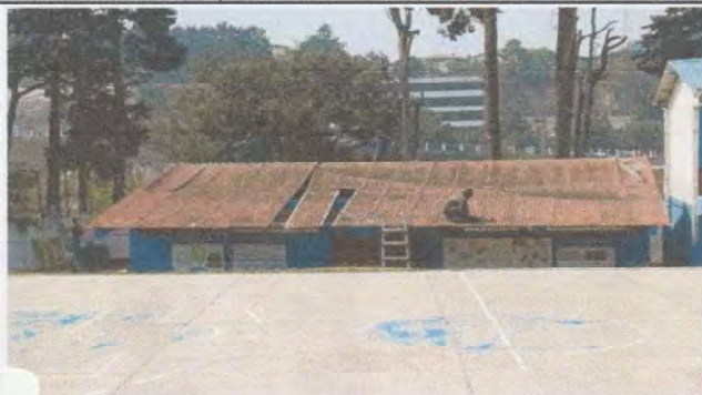
Foto 1: RETIRO DE LÁMINAS ANTIGUAS
