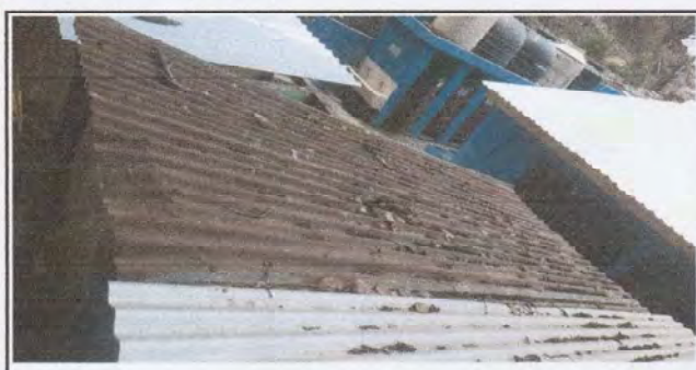
Foto 3: Retiro de láminas de baños
