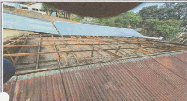
Foto 1: Sustrucción de lámina troquelada calibre 26 (aulas de párvulos, 4to grado, dirección y bodega)
