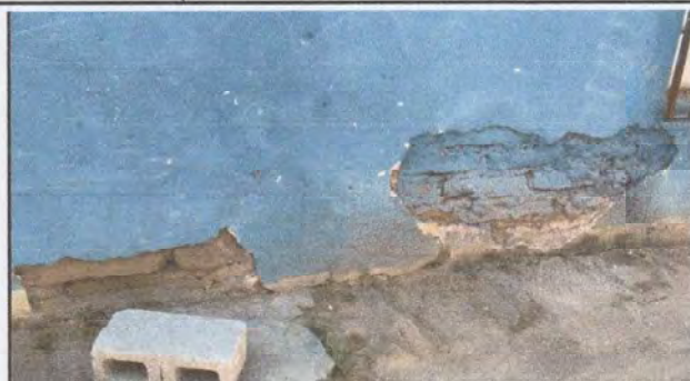
Foto 2: Mantenimiento de paredes parte trasera
