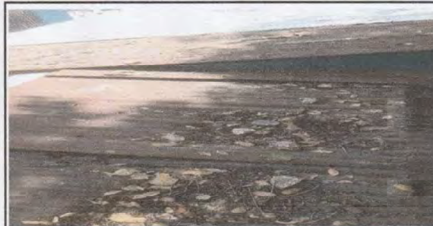
Foto 2: Vista exterior de las laminas en baños
