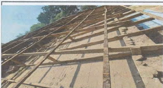
Foto 3: Retiro total de láminas en aulas de párvulos, 4to grado, dirección y bodega
