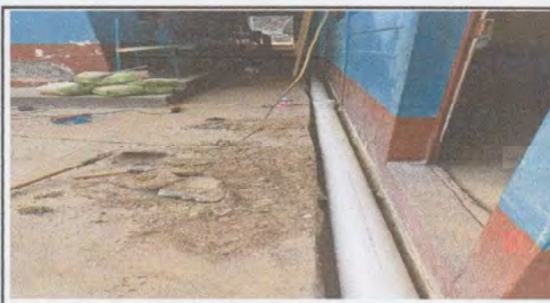
Foto 6: colocacion de tubos para la bajada de agua pluvial vista frontal
