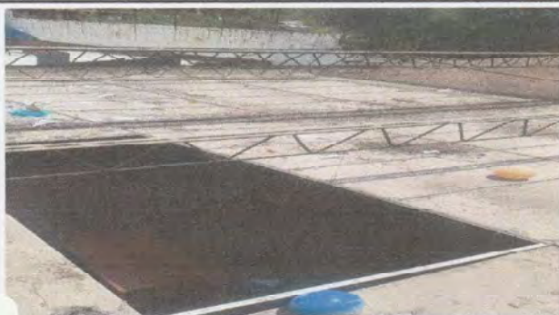
Foto 1: RETIRO DEL CIELO FALSO
