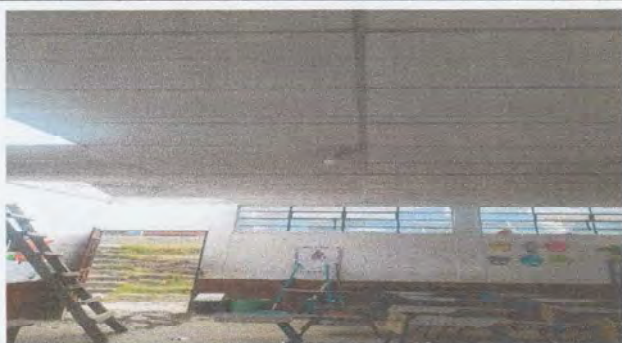
Foto 3: VISTA INTERIOR DEL RETIRO DEL CIELO FALSO
