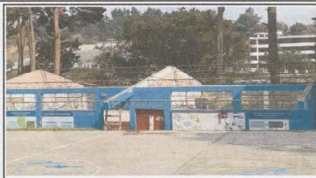
Foto 2: RETIRO TOTAL DE LÁMINAS
