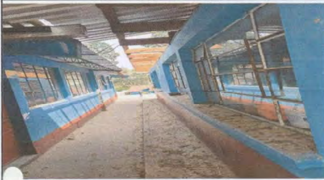
Foto 1: sustitucion de canales en aulas de parvulos
