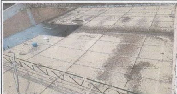
Foto 2: VISTA EXTERIOR DEL RETIRO DEL CIELO FALSO
