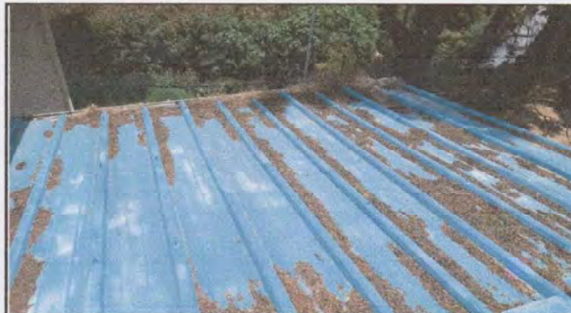
Foto 2: Vista desde arriba el mantenimiento de canales
