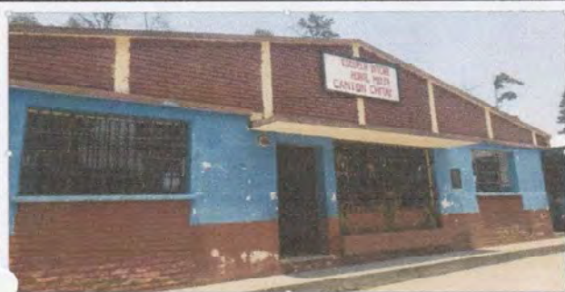
Foto 1: Mantenimiento de paredes de aulas de párvulos 4to grado, direccion y bodega
