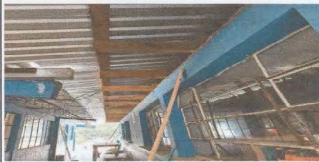
Foto 3: Retiro total de machimbre en aulas de párvulos y 4to grado
