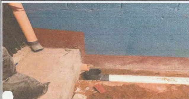
Foto1: Cambio de tubos para la bajada de aguas pluviales
