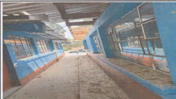
Foto 2: vista frontal de aulas sin balcones
