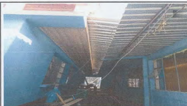
Foto 4: Sustitucion de balcones en aulas de párvulos y 4to grado
