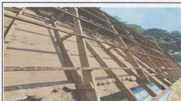
Foto 4: Retiro total de láminas en aulas de párvulos, 4to grado, dirección y bodega
