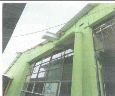
Foto 2: Sustitución de canal pvc por canal Galvanizado finalizado
