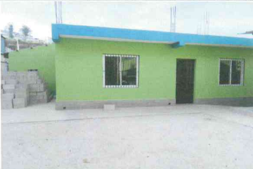
Foto 3: Instalación de Balcones en cocina para mejorar la seguridad finalizado con éxito.
