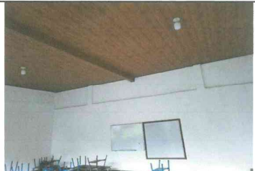
Foto 2: Instalación de cielo falso de pvc finalizado con éxito.
