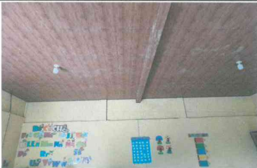
Foto 3: Instalación de cielo falso de pvc finalizado con éxito.
