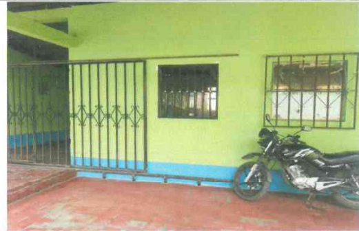
Foto 4: Instalación de balco en aula finalizado con éxito.
