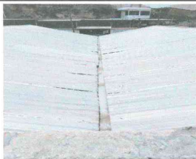
Foto1: Sustitución de canal pvc por canal Galvanizado finalizado
