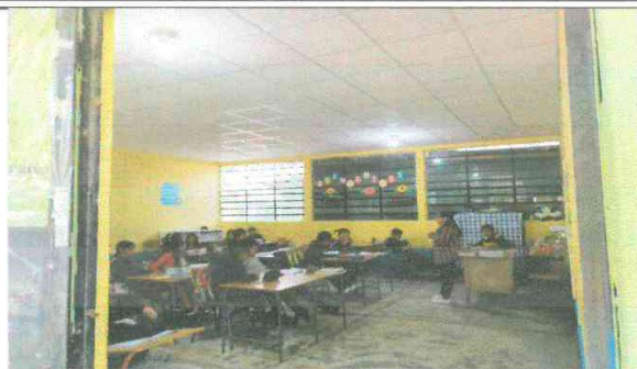
Foto1: Instalación de cielo falso finalizado con éxito.
