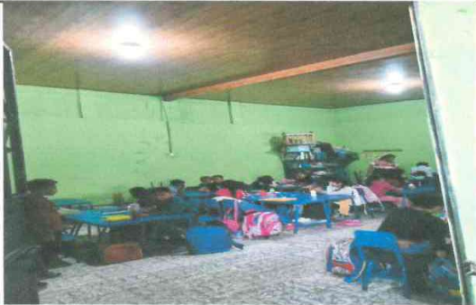
Foto 1: Instalación de cielo falso de pvc finalizado con éxito.
