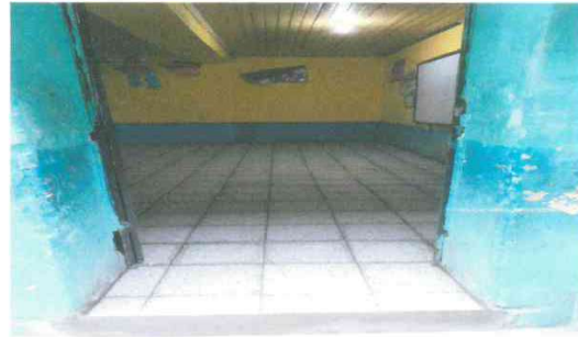
Foto 6: Sustitución de piso de concreto por piso de marmol finalizado
