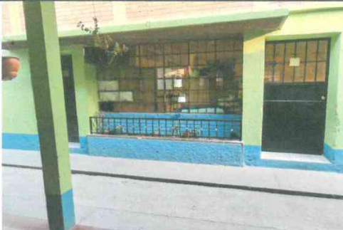
Foto 5: Instalación de baranda finalizada con éxito.
