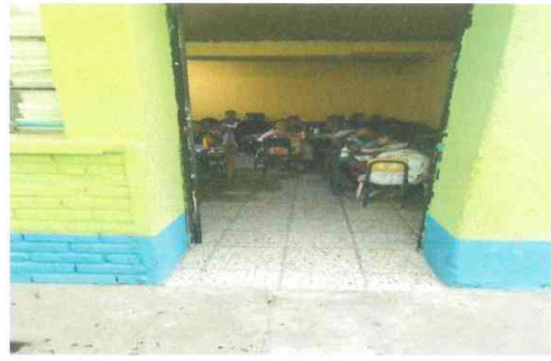
Foto 2: Sustitución de piso de concreto por piso de marmol finalizado
