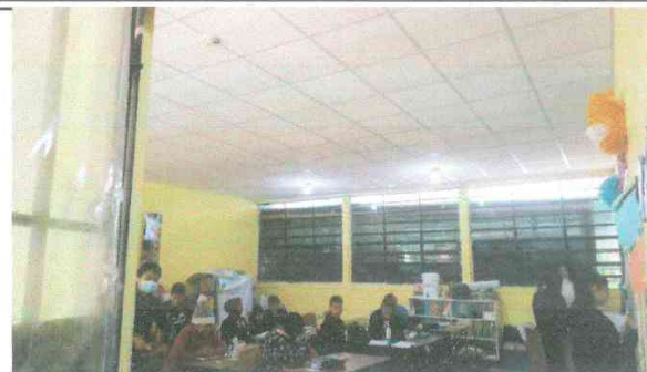
Foto 2: Instalación de cielo falso finalizado con éxito.
