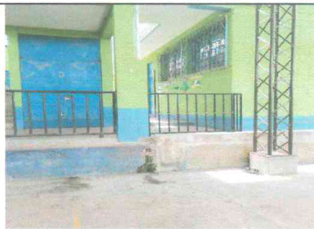
Foto 4: Sustitución de baranda de protección finalizado
