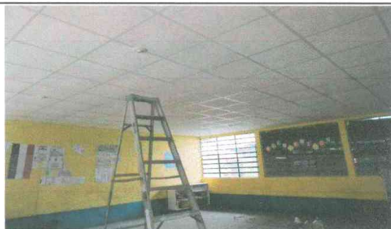
Foto 3: Instalación de cielo falso finalizado con éxito.
