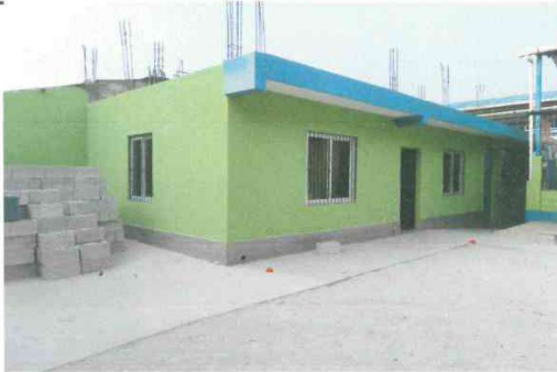
Foto1: Instalación de Balcones en cocina para mejorar la seguridad finalizado con éxito.
