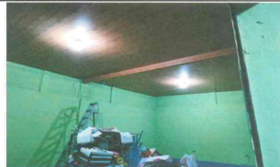
Foto 4: Instalación de cielo falso de pvc finalizado con éxito.
