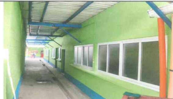
Foto 6: Sustitución de Ventanas de metal por ventanas de pvc.
