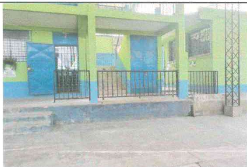
Foto 3: Sustitución de baranda de protección finalizado
