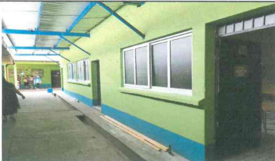
Foto 5: Sustitución de Ventanas de metal por ventanas de pvc.
