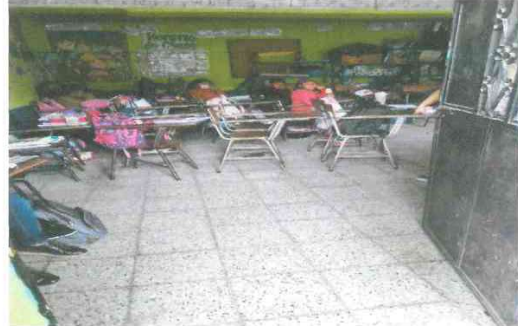
Foto 4: Sustitución de piso de concreto por piso de marmol finalizado
