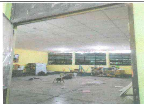
Foto 4: Instalación de cielo falso finalizado con éxito.
