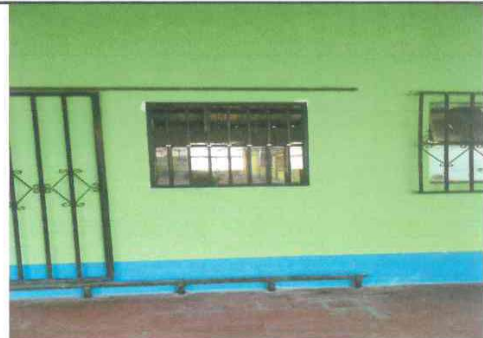
Foto 2: Instalación de balco en aula finalizado con éxito.
