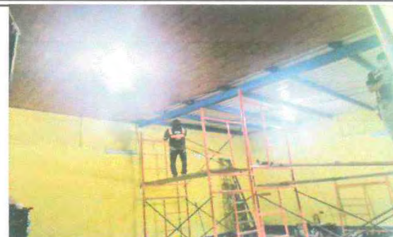
Foto 2: Proceso de instalación de cielo falso pvc en aulas con mucho calor
