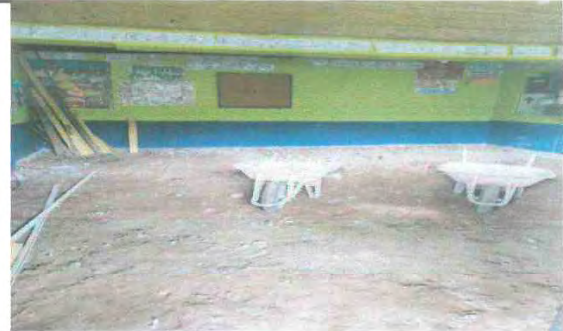
Foto 4: nivelación y compactación de suelo en área de trabajo.
