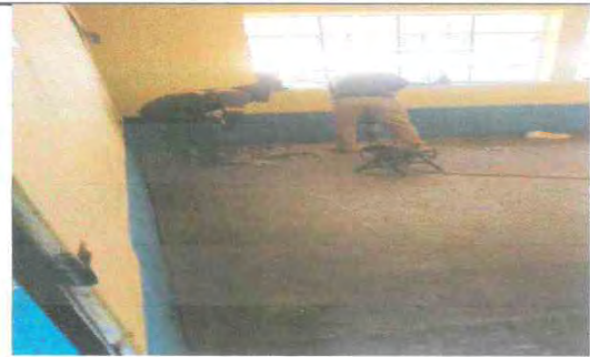
Foto 2: Demolición de piso de concreto existente.
