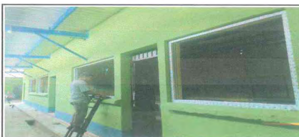
Foto 6: Proceso de instalación de nuevas ventanas de pvc para mejorar el ingreso de aire fresco.
