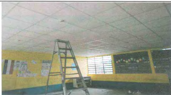
Foto 3: Proceso de instalación de cielo falso en aulas con mucho calor
