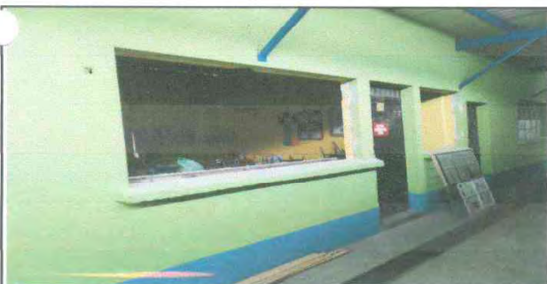
Foto 5: desinstalacion de ventanas existentes
