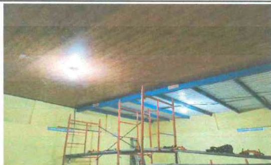
Foto1: Proceso de instalación de cielo Falsopvc en aulas con mucho calor
