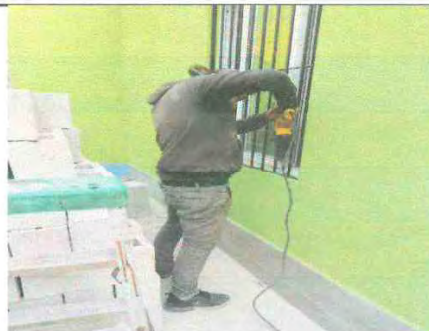
Foto 2: Instalación de balcon en cocina par mayor Seguridad
