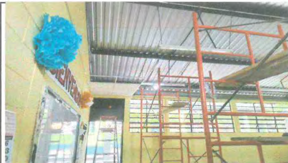
Foto 4: Proceso de instalación de cielo falso en aulas con mucho calor
