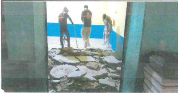
Foto1: Demolición de piso de concreto existente.
