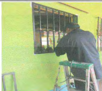
Foto 3: Instalación de balcon en aula par mayor Seguridad del centro educativo.
