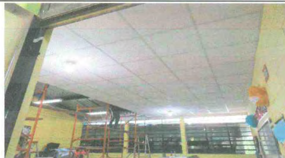
Foto 2: Proceso de instalación de cielo falso en aulas con mucho calor
