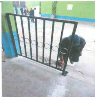
Foto 5: Instalacion de baranda de protección.
