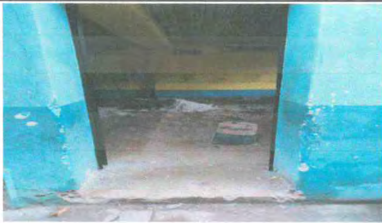
Foto 3: nivelación y compactación de suelo en área de trabajo.
