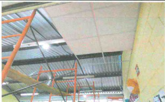
Foto1: Proceso de instalación de cielo Falso en aulas con mucho calor
