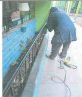
Foto 6: Instalación de Baranda
