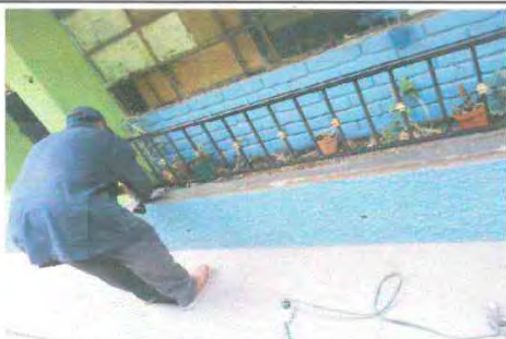
Foto 5: Instalación de Baranda
