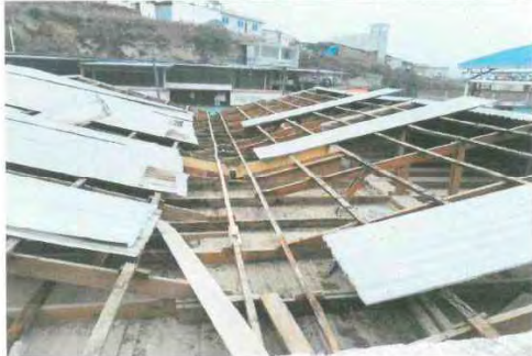
Foto1: Desmonte de lamina para cambio de canal
