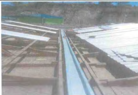
Foto 3: Instalacion de canal nuevo.
