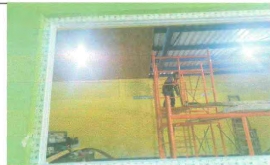
Foto 4: Proceso de instalación de cielo falso pvc en aulas con mucho calor
