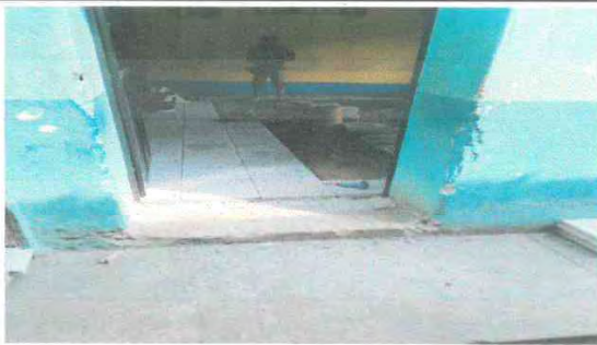
Foto 5: Proceso de instalación de piso marmol.
