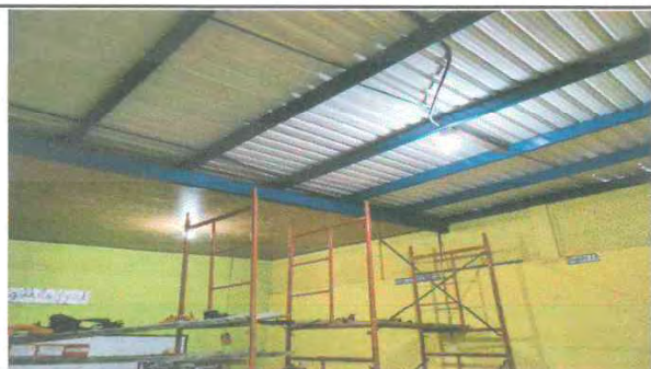
Foto 3: Proceso de instalación de cielo falso pvc en aulas con mucho calor
