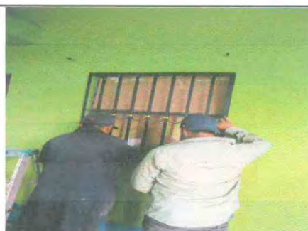
Foto 6. Instalacion de balcon de seguridad en aula
