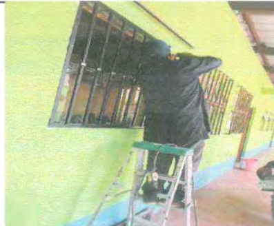
Foto 4: Instalación de balcon en aula par mayor Seguridad del centro educativo.
