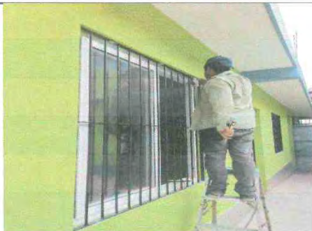
Foto1: Instalación de balcon en cocina par mayor Seguridad
