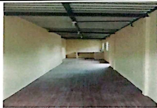
Vista de suministros e instalación de techo
