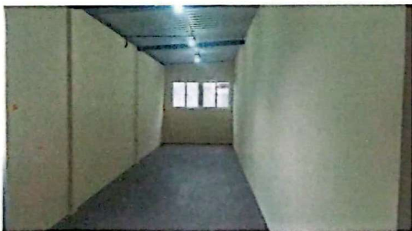
Interior de la cocina con suministro e instalación de estructura metálica
