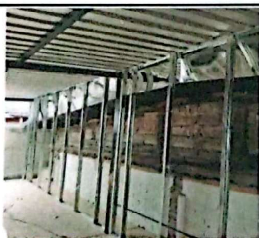
Mantenimiento de cocina
