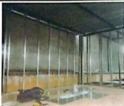
Suministro e instalación de techo, suministro e instalación de entrepiso de estructura metálica
