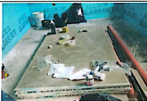
Suministro e instalación de entrepiso de estructura metálica
