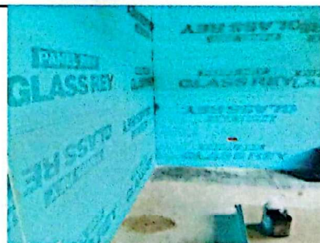
Suministro e instalación de techo
