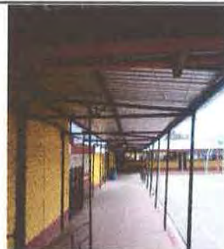
REPARACIÓN ESTRUCTURA PORTANTE DE TECHO EN PASILLO
