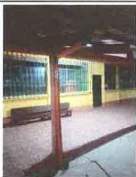
REPARACIÓN ESTRUCTURA PORTANTE DE TECHO EN PASILLO
