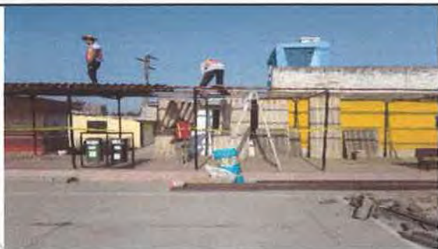
SUSTITUCIÓN DE LAMINA DURALITA POR LAMINA TROQUELADA ALUZINC CALIBRE 26 EN PASILLO
