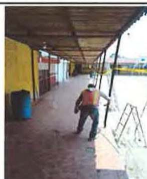
REPARACIÓN ESTRUCTURA PORTANTE DE TECHO EN PASILLO
