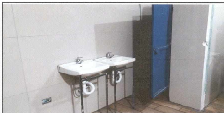
Foto 3: VISTA INTERIOR DE INSTALACION DE PORCELANATO DE BAÑOS
