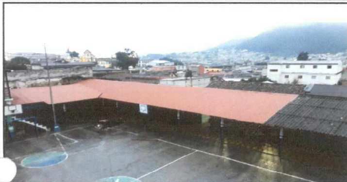
Foto 1: VISTA FACHADA INTERIOR LAMINA COLOCADA AL 100%
