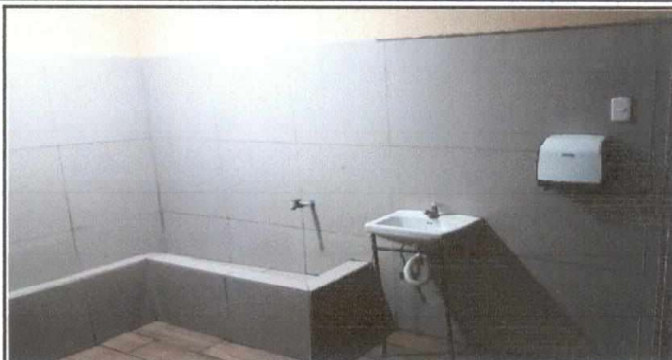
Foto 2: VISTA DE INSTALACIÓN DE PORCELANATO 100%
