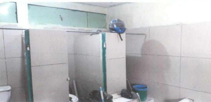
Foto 5: Suministro de porcelanato primera fase
