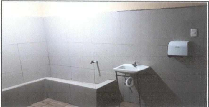
Foto 6: Finalización de instalación de porcelanato y cerámico de baños
