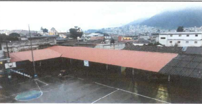
Foto 3: Finalizada la colocación de láminas
