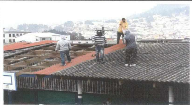
Foto 2: SUMINISTRO E INSTALACIÓN DE LÁMINA PRIMERA FASE
