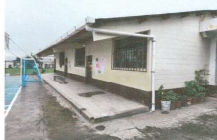
Foto 2: VISTA DE INSTALACIÓN DE CANAL FINALIZADO
