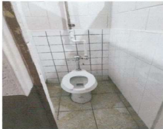
Foto 5: VISTA DE CAMBIO E INSTALACION DE INODOROS FINALIZADO AL 100%
