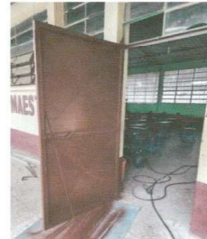
Foto 4: VISTA REPARACIÓN DE PUERTA Y MARCO EN AULA FINALIZADO
