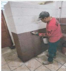
FOTO 9: APLICACION DE PINTURA
