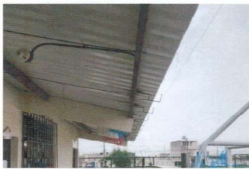
FOTO 11: COLOCACIÓN DE CANAL
