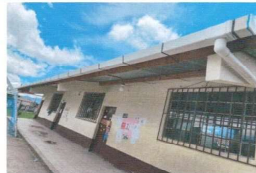
FOTO 12: INSTALACIÓN DE CANAL
