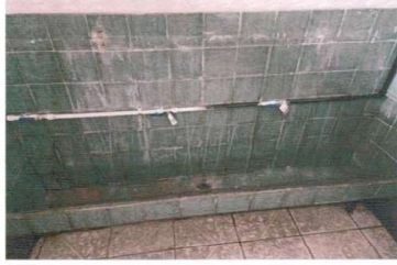
Foto 7: COLOCACIÓN DE MIGITORIO
