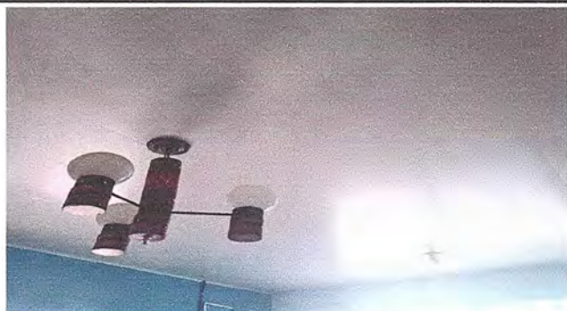
Instalación de cielo falso de PVC
