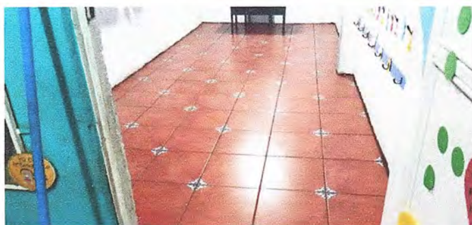
Sustitución de piso en corredores y aulas
