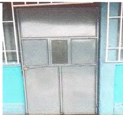
Mantenimiento de puertas
