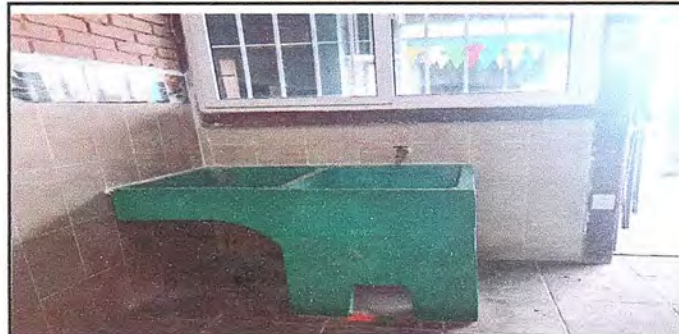
Suministro e instalacion de pila
