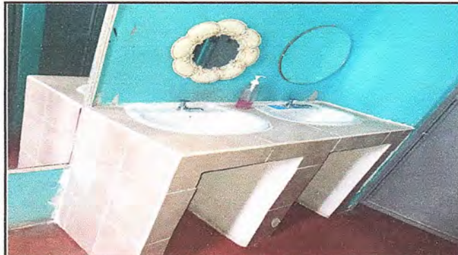
Sustitucion de lavamanos y mesas soporte
