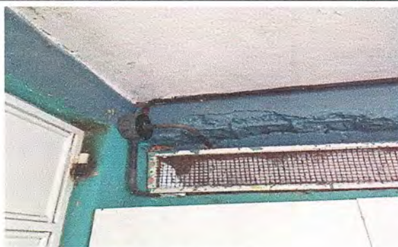
Mantenimiento de sistema eléctrico general
