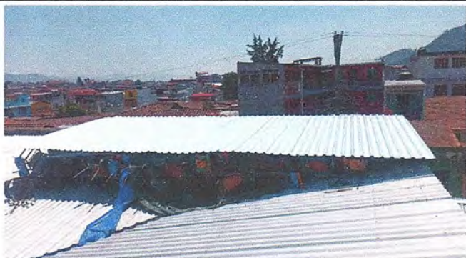
Sustitución de lamina en techo de aula por lamina troquelada calibre 26
