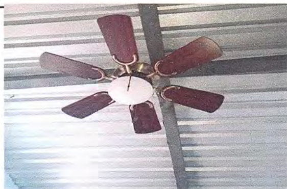
Sustitución de ventiladores
