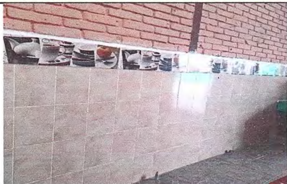
Mantenimiento de cocina
