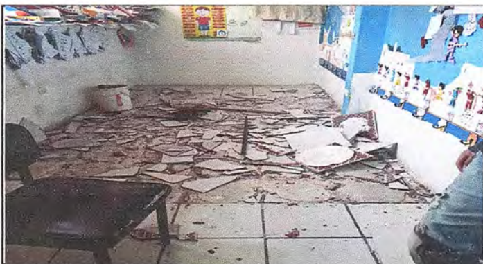
Sustitución de piso en corredores y aulas
