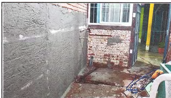
Suministro e instalación de pila
