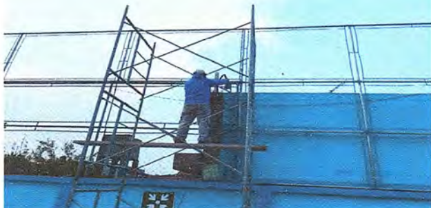
Sustitución de malla metálica con tubo galvanizado
