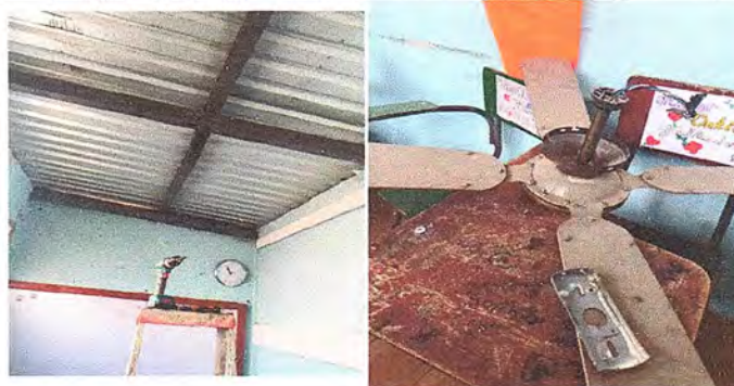
Sustitución de ventiladores
