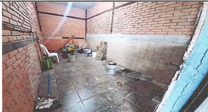
Mantenimiento de cocina
