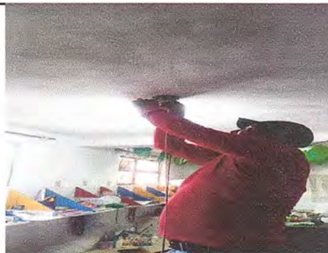
Mantenimiento de sistema eléctrico general
