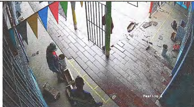
Sustitución de piso en corredores y aulas
