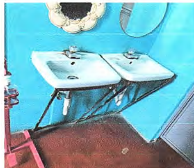
Sustitucion de lavamanos y mesas soporte
