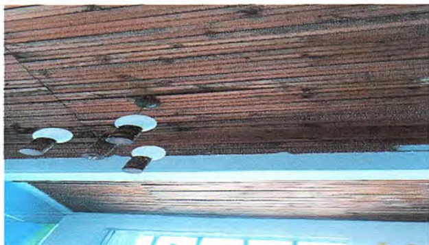
Instalación de cielo falso de PVC
