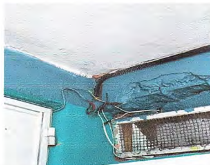
Mantenimiento de sistema electrico general
