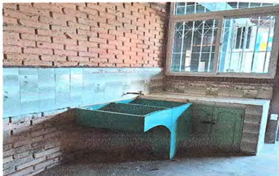
Mantenimiento de cocina
