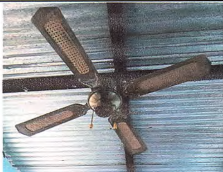
Sustitución de ventiladores
