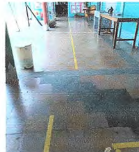
Sustitución de piso en corredores y aulas
