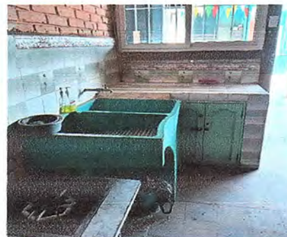
Suministro e instalacion de pila
