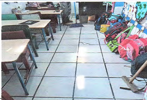
Sustitucion de piso en corredores y aulas
