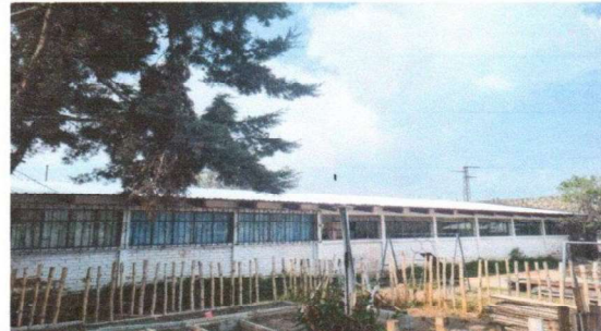
Foto 2: VISTA DE INSTALACIÓN DE LÁMINA FINALIZADO
