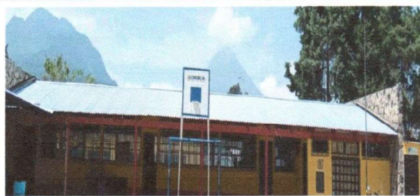
Foto 1: VISTA INSTALACION COMPLETA DE LAMINA
