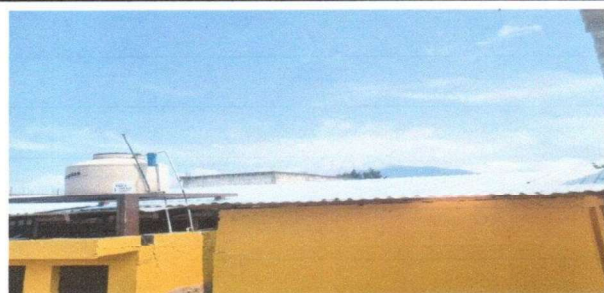
Foto 3: VISTA INSTALACION DE LAMINA TERMINADA
