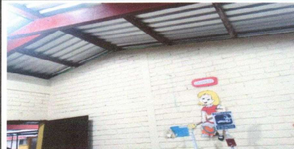
Foto 4: VISTA SUMINISTRO E INSTALACIÓN DE LAMINAS POR DENTRO DE AULA
