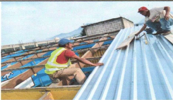
Foto 3: SUMINISTRO E INSTALACIÓN DE LAMINAS TROQUELADAS CALIBRE 26
