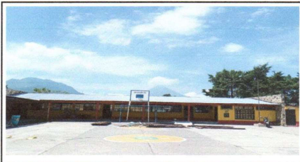
Foto 6: FINALIZA LA COLOCACIÓN DE LÁMINAS
