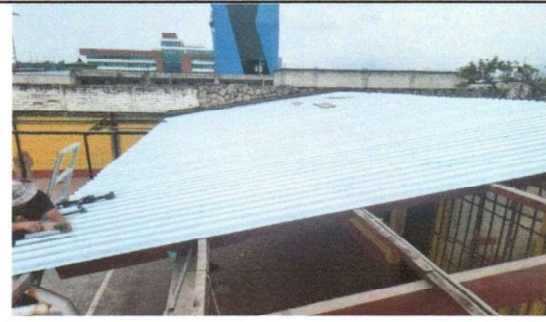
Foto 4: SUMINISTRO E INSTALACION DE LAMINAS TROQUELADAS CALIBRE 26
