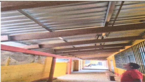
Foto 5: SUMINISTRO E INSTALACIÓN DE LÁMINAS CALIBRE 26 Y TENDALES TUBO CUADRADO 2"X2" CH16
