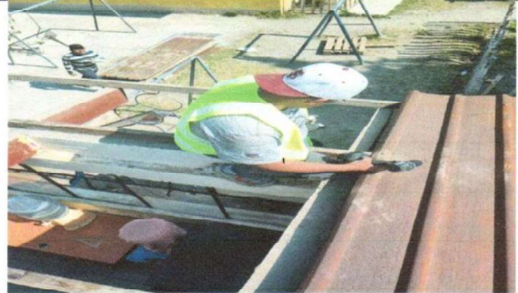
Foto 2: RETIRO DE LAMINAS ANTIGUAS
