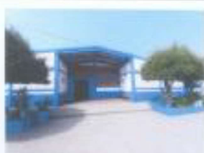
Foto 4: VISTA DE PINTURA DE PAREDES.
