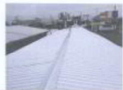
Foto 5: SUSTITUCIÓN DE TECHO DE LÁMINA ASBESTO
