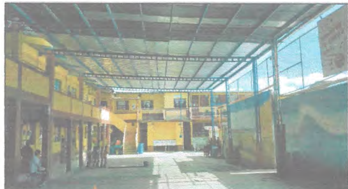
Sustitución de lámina por lámina troquelada calibre 26
