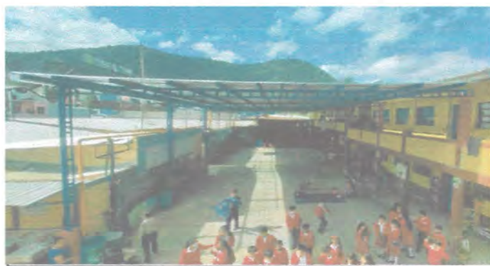
Sustitución de lámina por lámina troquelada calibre 26
