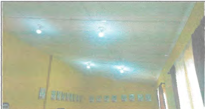
Sustitución de cielo falso reticulado
